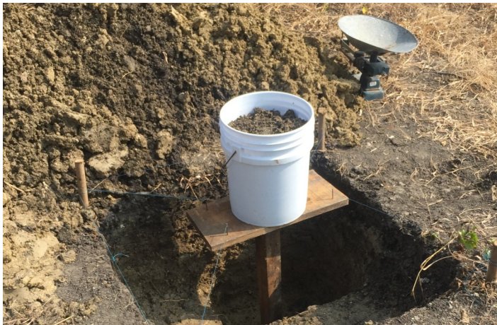
Imagen 29. Estudio de mecánica de suelo en sitio, prueba de polín. Elaboración propia.
