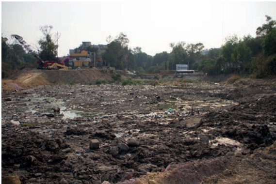
Vista al Parque ojo de agua Proceso de desasolve
