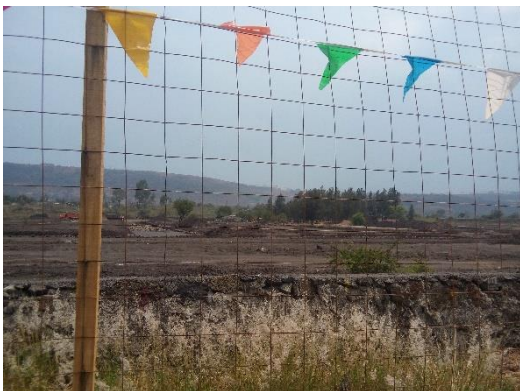
Imagen 20. Fraccionamiento en construcción
