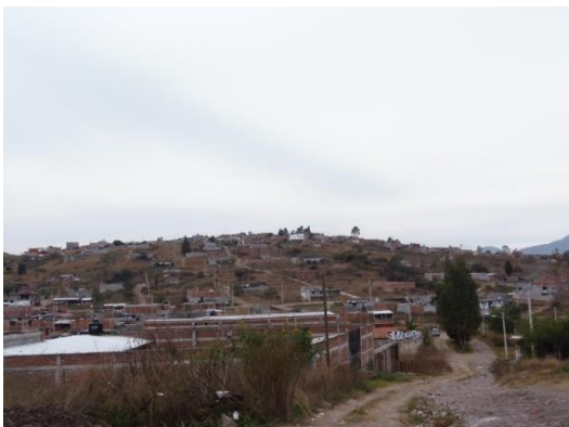
Imagen 3. Autoconstrucción de vivienda en la Aldea Fuente: Archivo propio de enero de 2016
