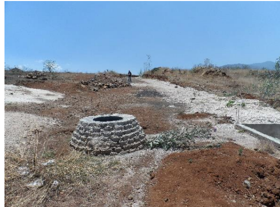
Imagen 19. Instalación de drenaje Arko San Pedro
