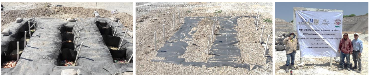
Figura 4.9 Construcción de celdas / Recubrimiento de celdas / Lona de identificación de proyecto
