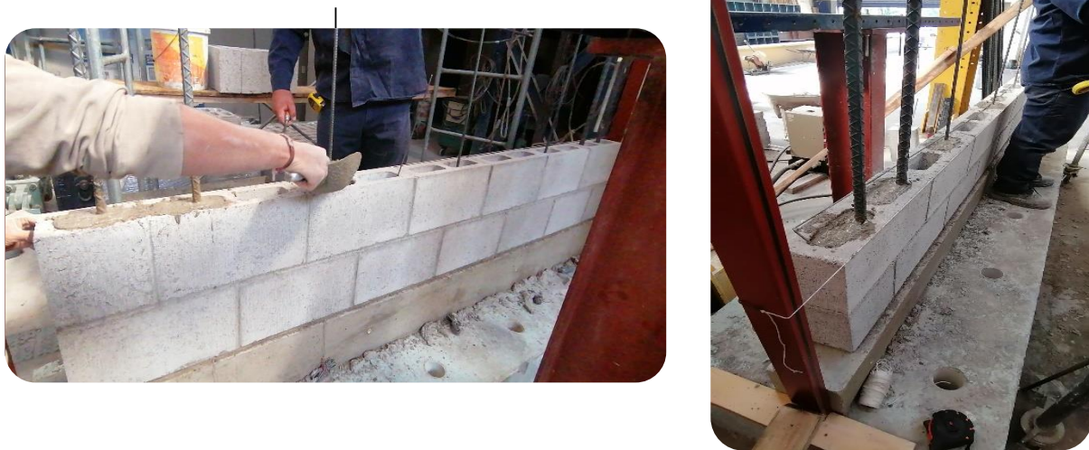
Figura 4.7 Relleno de celdas con refuerzo
