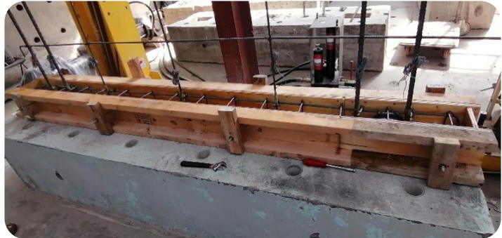
Figura 4.4 Armado de muro con refuerzo interior
