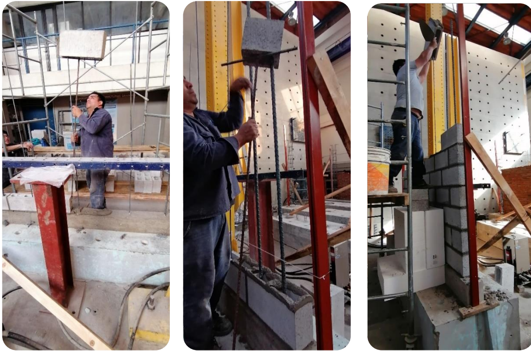
Figura 4.6 Colocación de bloques con ayuda de una barra
