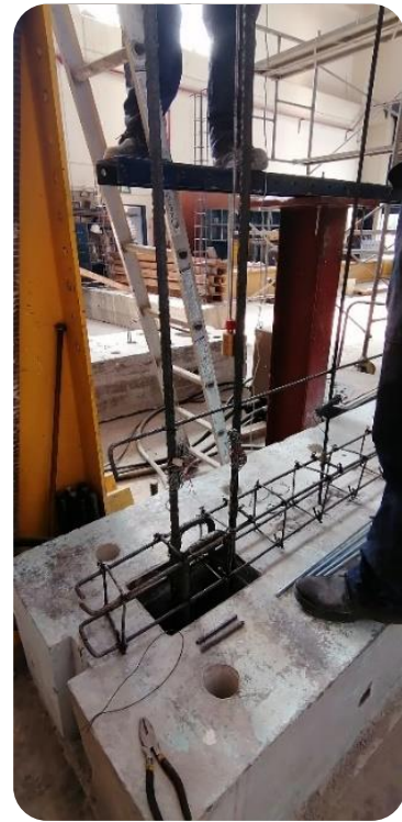
Figura 4.4 Armado de muro con refuerzo interior
