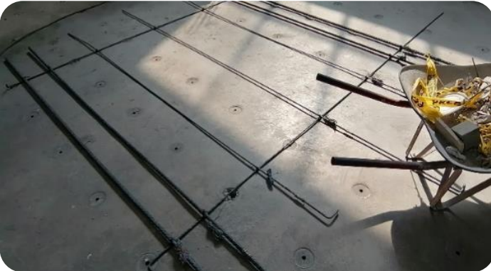
Figura 4.4 Armado de muro con refuerzo interior
