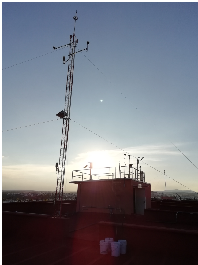
FIGURE 2.4: Estación en Juriquilla, Querétaro, donde se encuentra uno de nuestros monitores de campo eléctrico.
