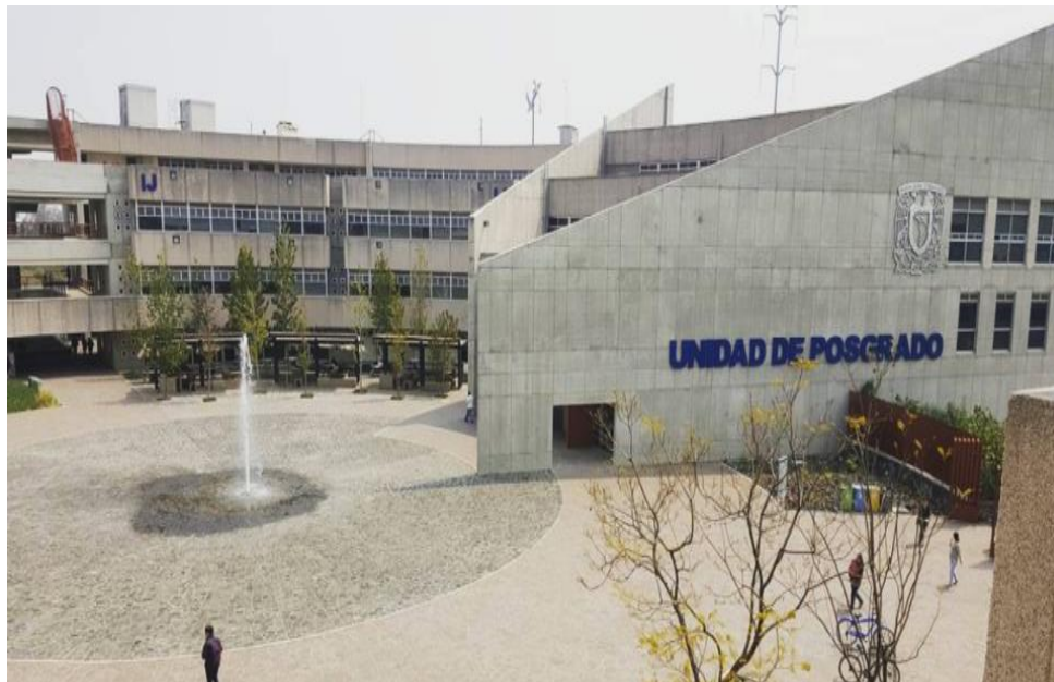
Ilustración 13 Unidad de Posgrados UNAM, 2013, Ciudad de México, México, Dirección General de Obras y Conservación (DGOC). Extraída con fines didácticos de: Fotografía: @terejaromo https://www.instagram.com/p/BQyRC_53FN5N/?taken-by=terejaromo
