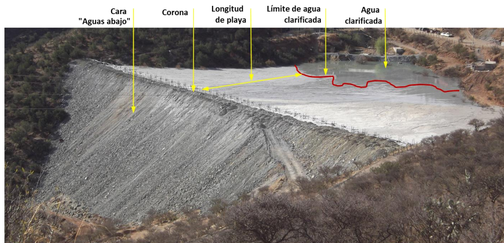
Figura 1-6 Presa de Jales con el método “aguas arriba” (Flores, 2019).
