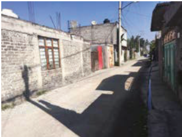
Construcción de cunetas pluviales
