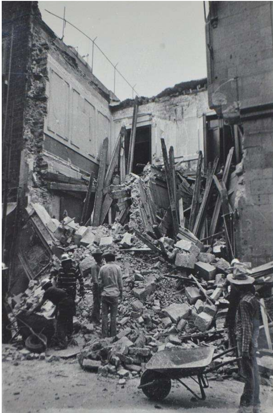
Demolición del inmueble en Argentina 9, 3 de junio de 1980. Templo Mayor, exp, 32-28 al 32-31, año 1980, Foto: [CNA].
