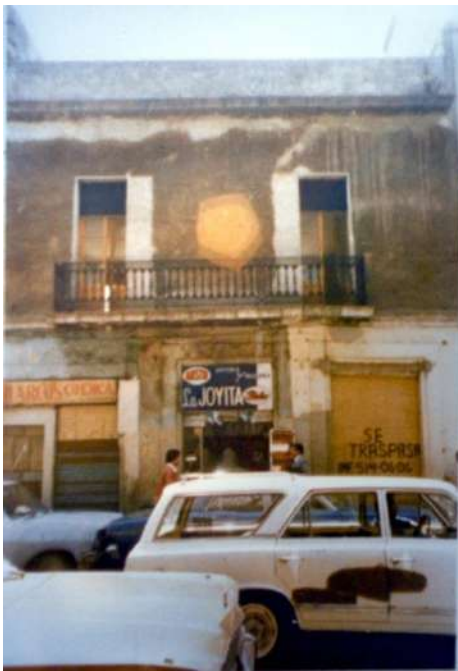
Fachada principal de la casa Justo Sierra 13. Foto: [CNMH].
