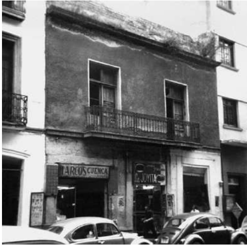
Vista frontal desde la calle Justo Sierra núm. 13, Foto: [CNMH].
