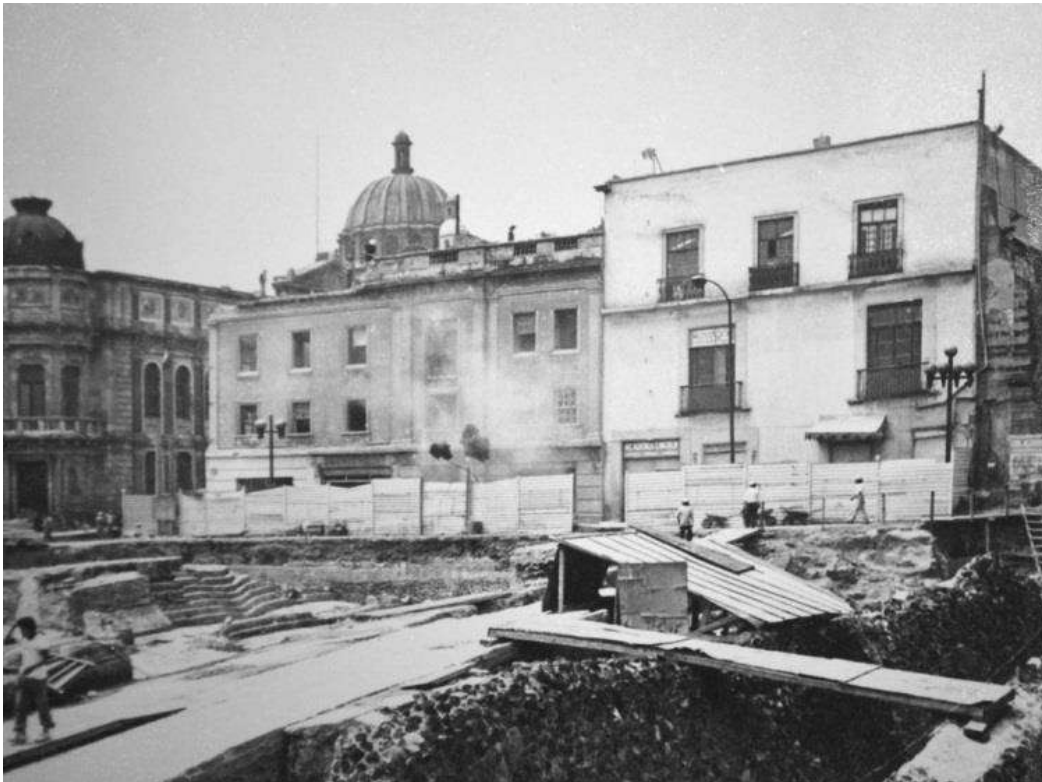
Demolición del tercer piso, a la derecha Academia Lincoln, Templo Mayor, exp, 32-28 al 32-31, año 1980, Foto: [CNA].
