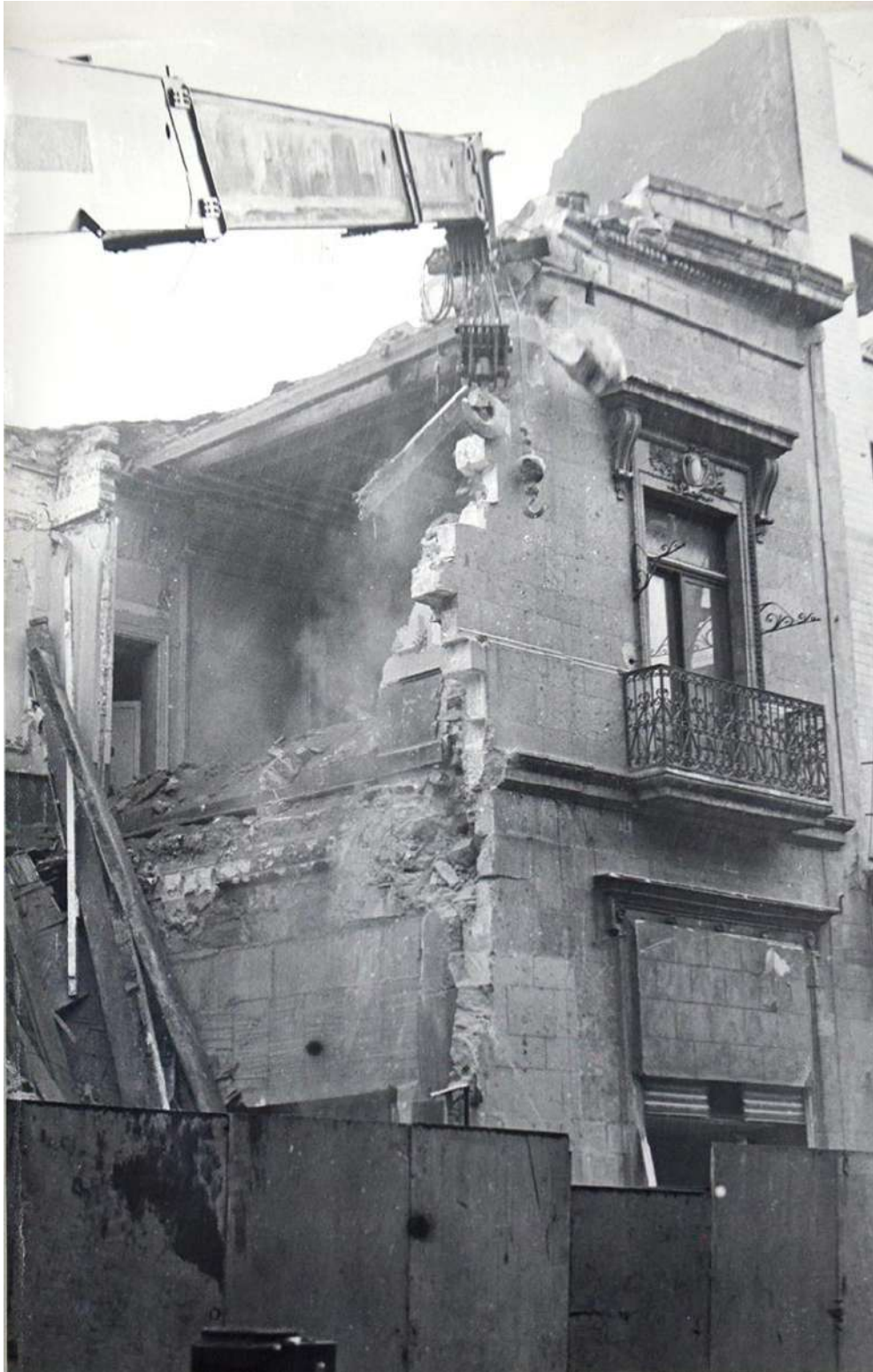
Demolición del inmueble en Argentina 9, 3 de junio de 1980. Templo Mayor, exp, 32-28 al 32-31, año 1980, Foto: [CNA].
