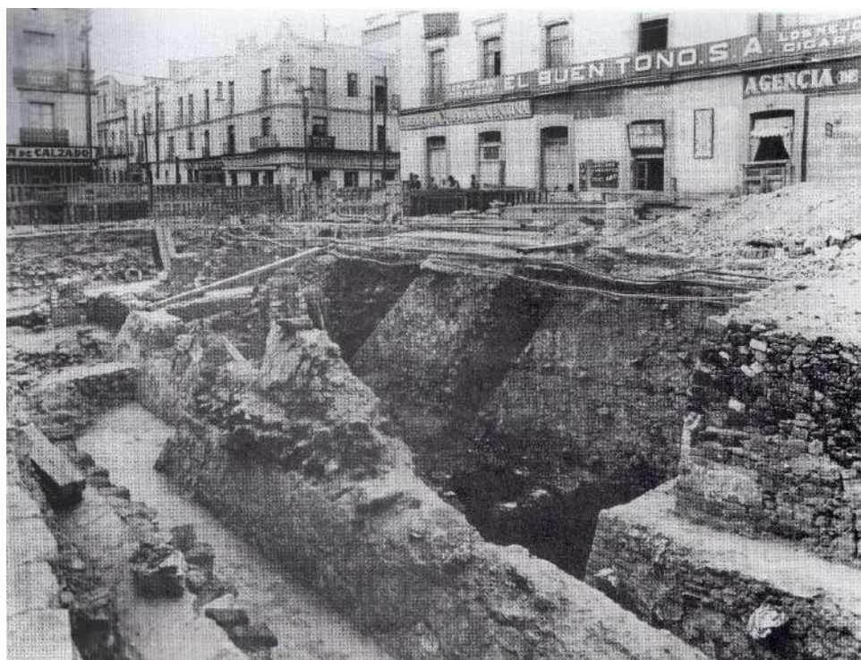
Vestigios del Templo Mayor bajo la demolición de la casa número 9 de la condesa de Peñalba en 1914. A la izquierda la Librería Robredo. Foto: [CNMH].
