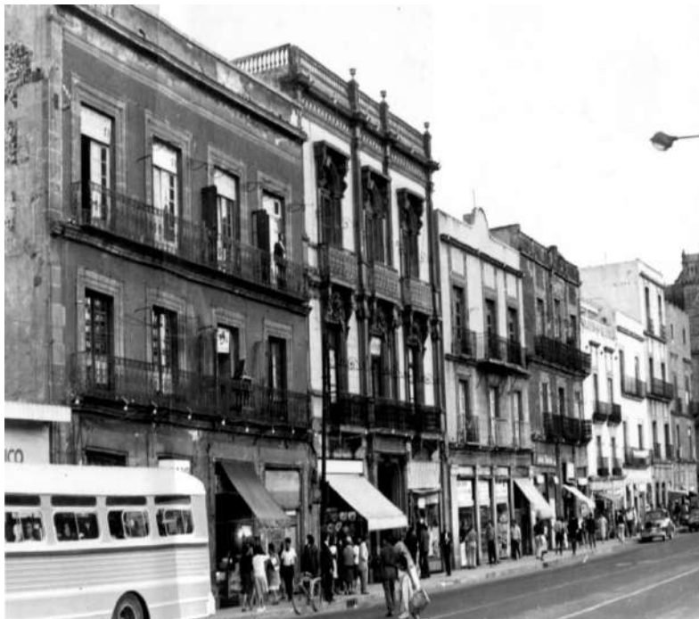
Vista de la casa hacia el sur, Foto: [CNMH].
