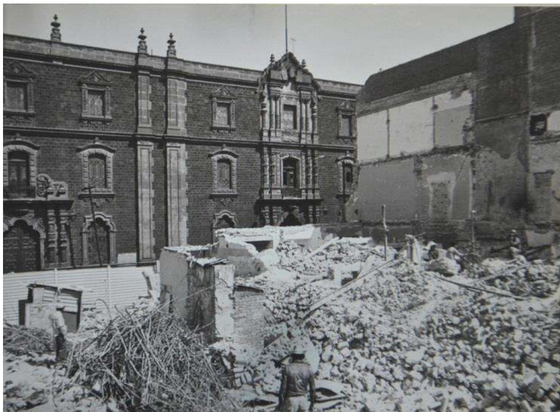
Demolición Justo Sierra 15, febrero 1981, Templo Mayor, exp, 32-36 al 32-38, año 1981, Foto: [CNA].
