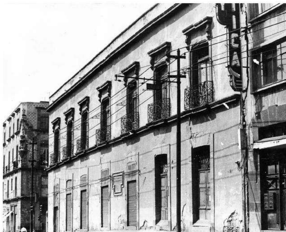
“Casa que se reedificó sobre el solar de Alonso de Ávila en el siglo XIX, 1928. En la imagen se observa el padrón colocado en ese sitio en 1928”. FCRV-CNMAH-INAH. AA01. 697
