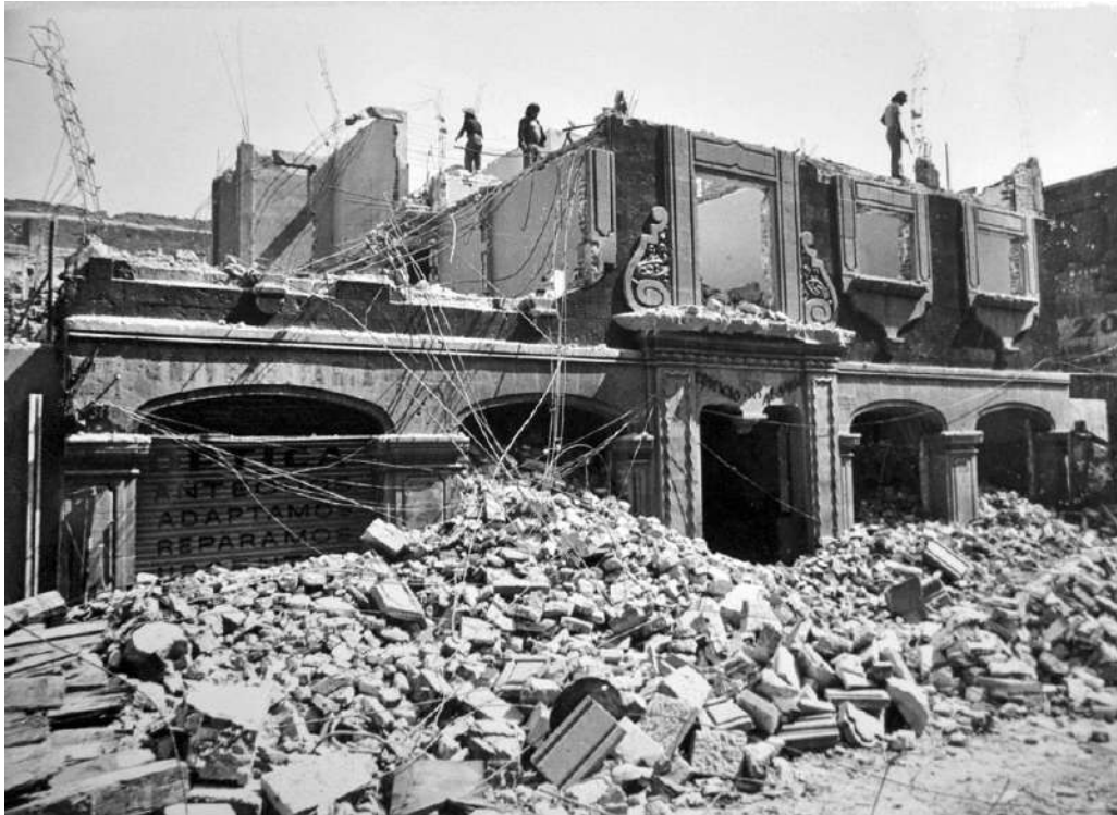
Demolición Edificio Álamos, Templo Mayor, exp, 32-28 al 32-31, año 1980, Foto: [CNA].
