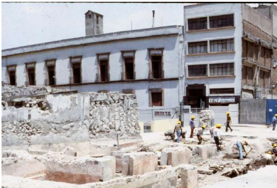
Desplantes de muros de casa habitación con aplanado rojo bajo el pavimento en el estacionamiento del Museo Etnográfico. Al fondo Librería Robredo y farmacia Vely. Foto: [MTM].
