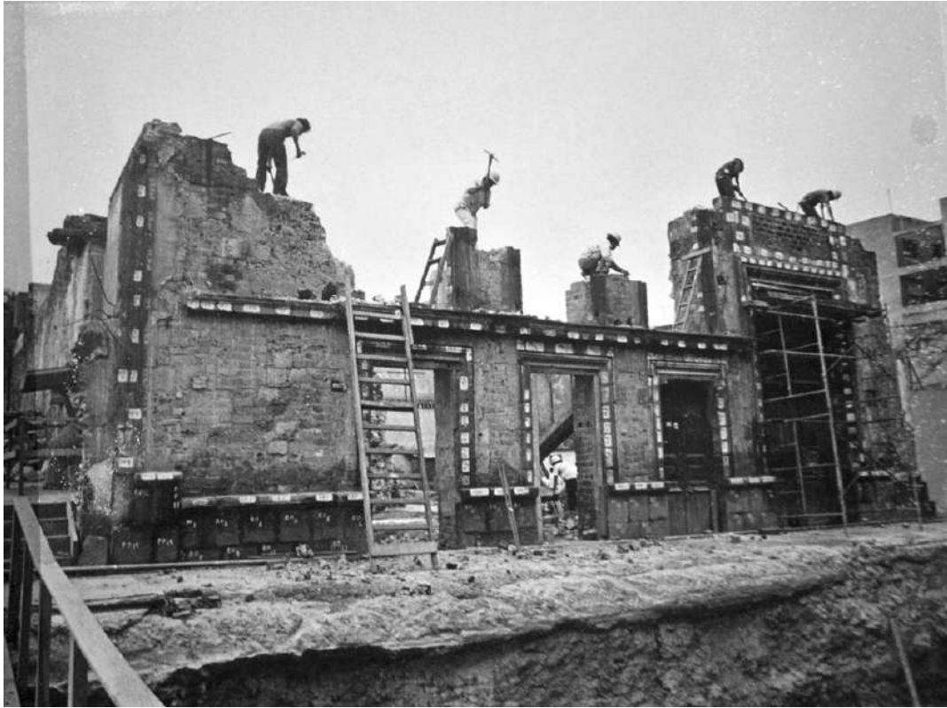
Numeración de piezas para desmonte. Edificio en Guatemala 50, Templo Mayor, exp, 32-21 al 32-24, año 1979. Foto: [CNA].
