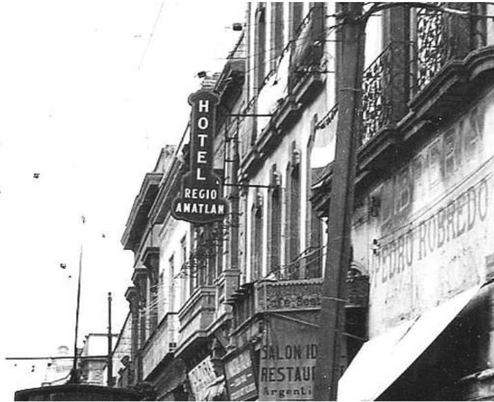
Calle Argentina, detalle, Foto: [CNMH].
