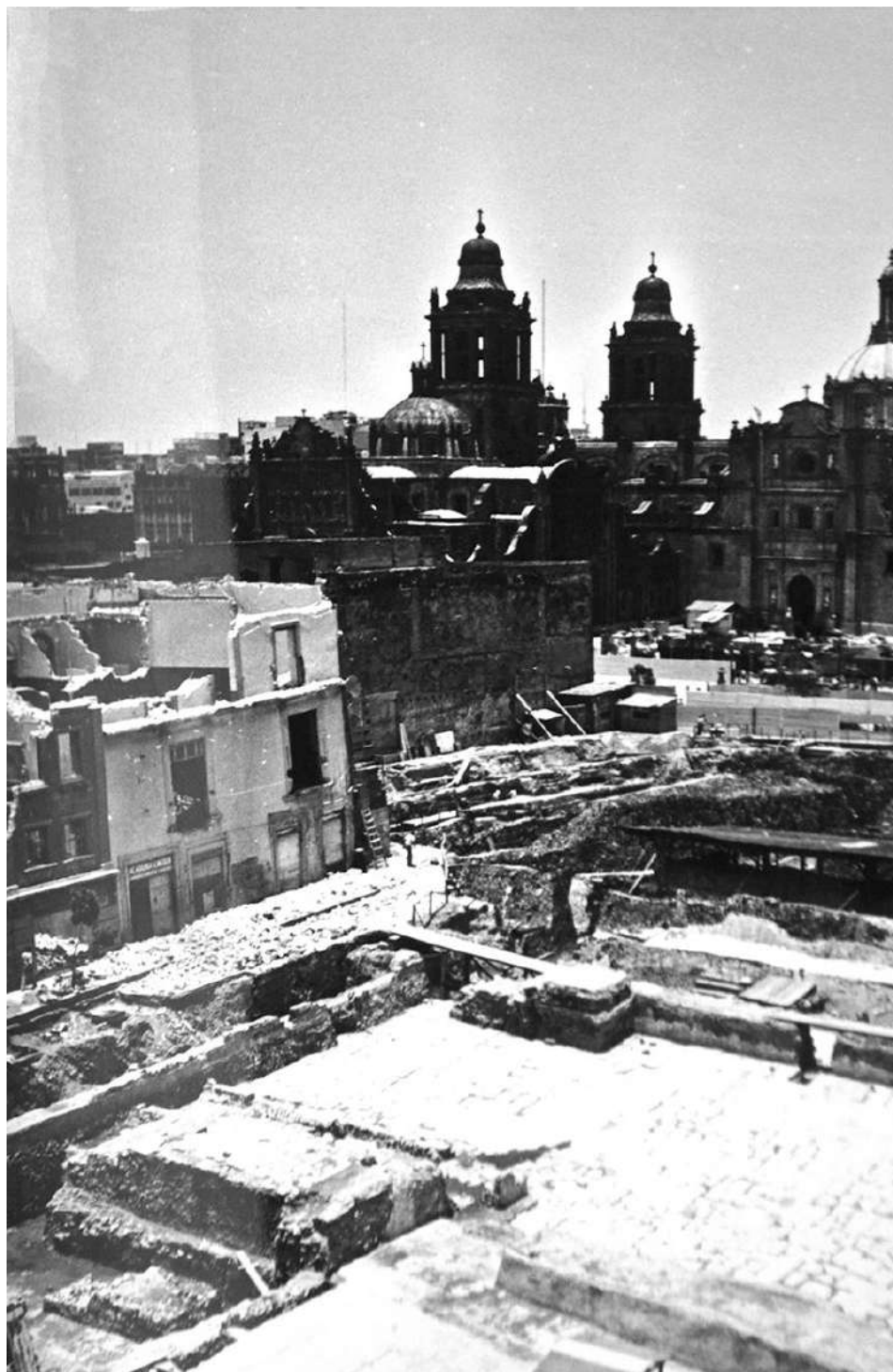
A la izquierda demolición de los edificios Guatemala 49 y 51/53, Templo Mayor, exp, 32-28 al 32-31, año 1980, Foto: [CNA].
