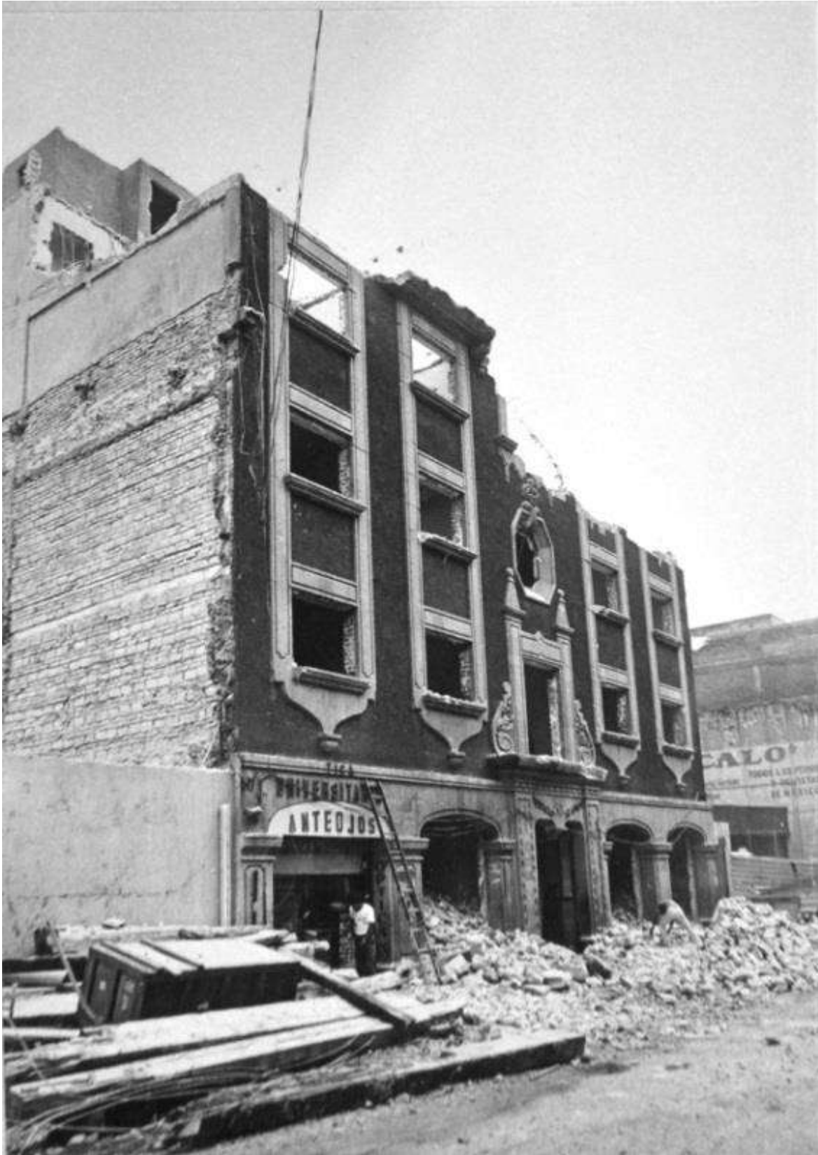
Demolición Guatemala 58, Templo Mayor, exp. 32-28 al 32-31, año 1980, Foto: [CNA].
