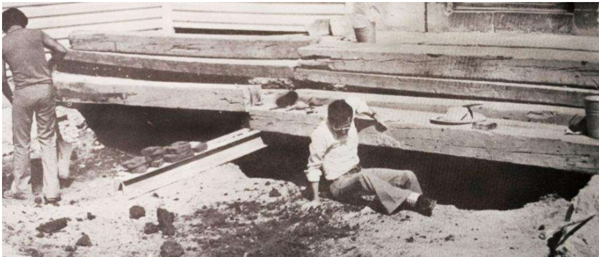
Inspección de los primeros días de trabajos por parte del Arqlo. Raúl Arana. Coyolxauhqui, aún oculta bajo la calle de Guatemala y la librería Robredo. Foto: [CNA]. Templo Mayor, exp. 32-1 al 32-3, año 1978.
