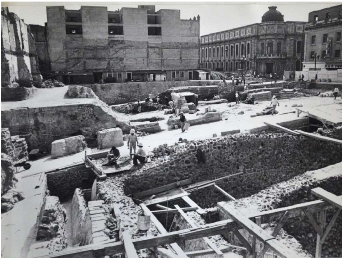
Edificio Guatemala 58. Templo Mayor, exp, 32-28 al 32-31, año 1980, Foto: [CNA].
