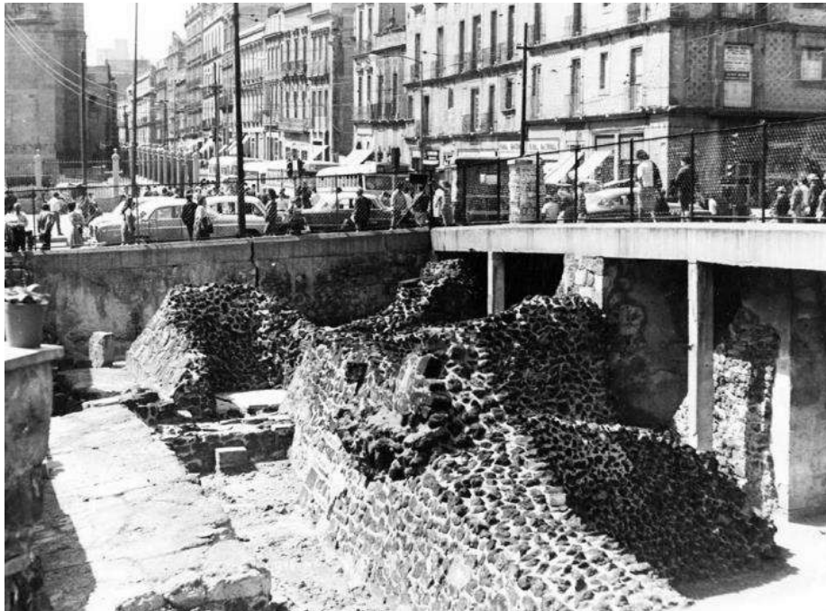
Límite de la excavación hacia la calle Seminario. Foto. [Mediateca INAH].
