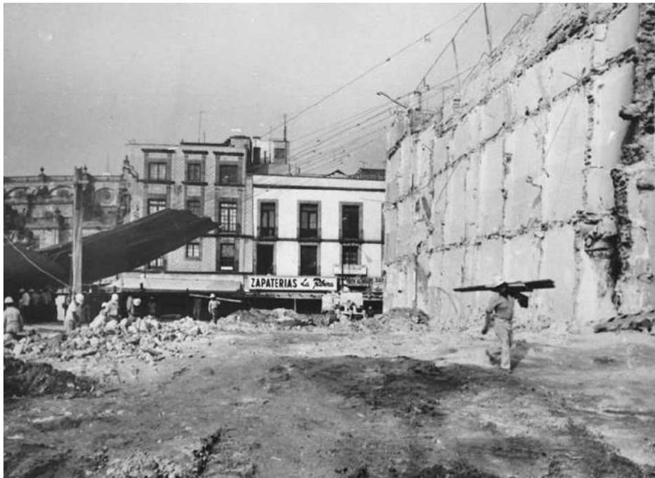
Demolición Hotel Amatlán, Foto: [CNA].
