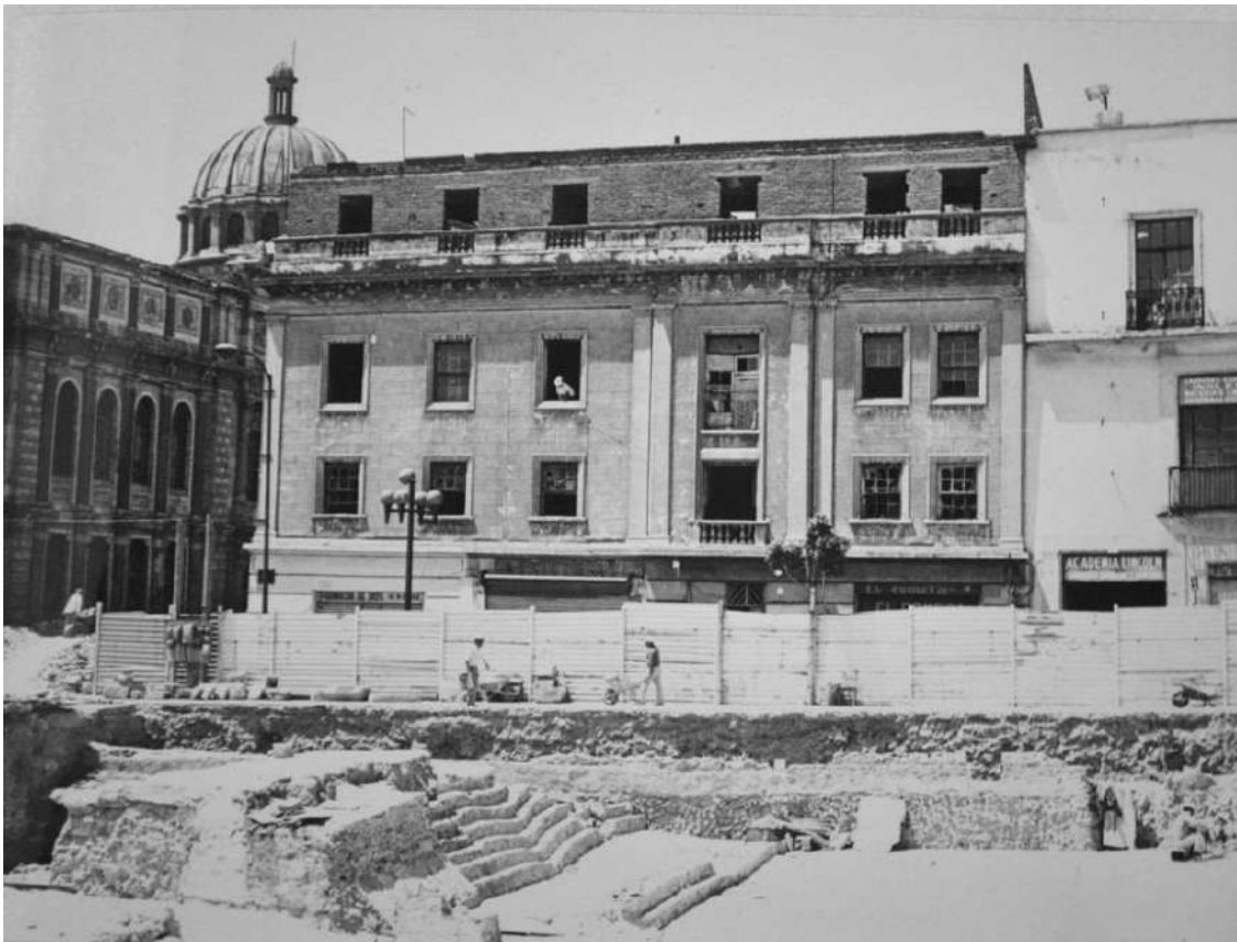
Edificio de Guatemala 51 con el agregado del tercer piso, Templo Mayor, exp, 32-28 al 32-31, año 1980,
