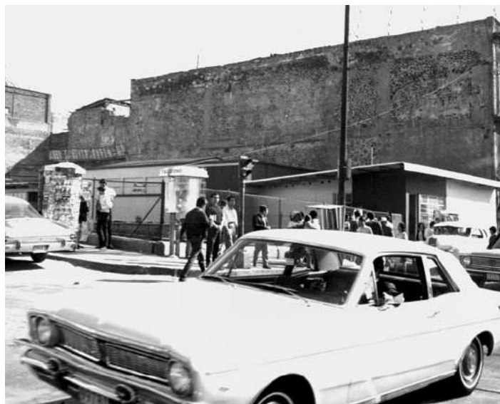
Cruce de Seminario y Guatemala, al fondo las ruinas del Templo Mayor abajo y al fondo el Museo Etnográfico; la gran pared corresponde a la casa de Seminario 6 (demolida), Foto: [CNMH].
