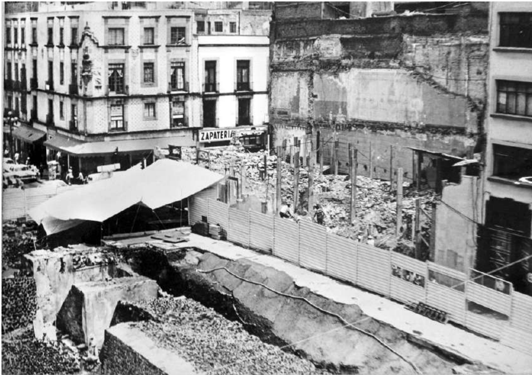
Demolición de la Librería Robredo. Templo Mayor, exp: 32-4 al 32-6, año 1978, Foto: [CNA].
