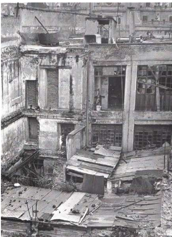
Casa en ruinas en la calle de Seminario 6, al fondo, la Catedral Metropolitana, Foto: [SGA].
