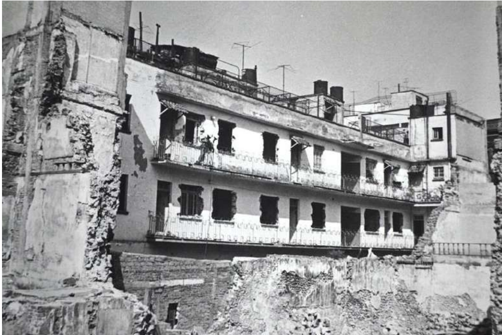
Demolición Justo Sierra 11, diciembre 13 de 1979. Templo Mayor, exp, 32-21 al 32-24, año 1979, Foto: [CNMH].
