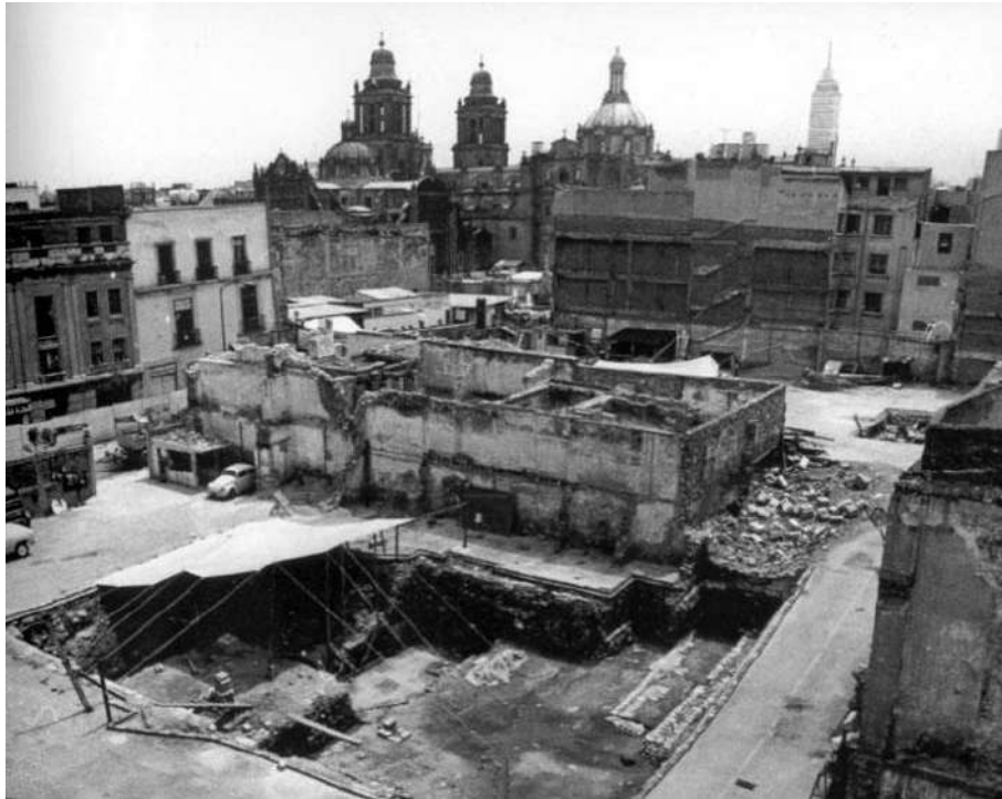
Vista general del extenso predio del estacionamiento de la SHCP. Guatemala 44-56. Foto: [MTM].
