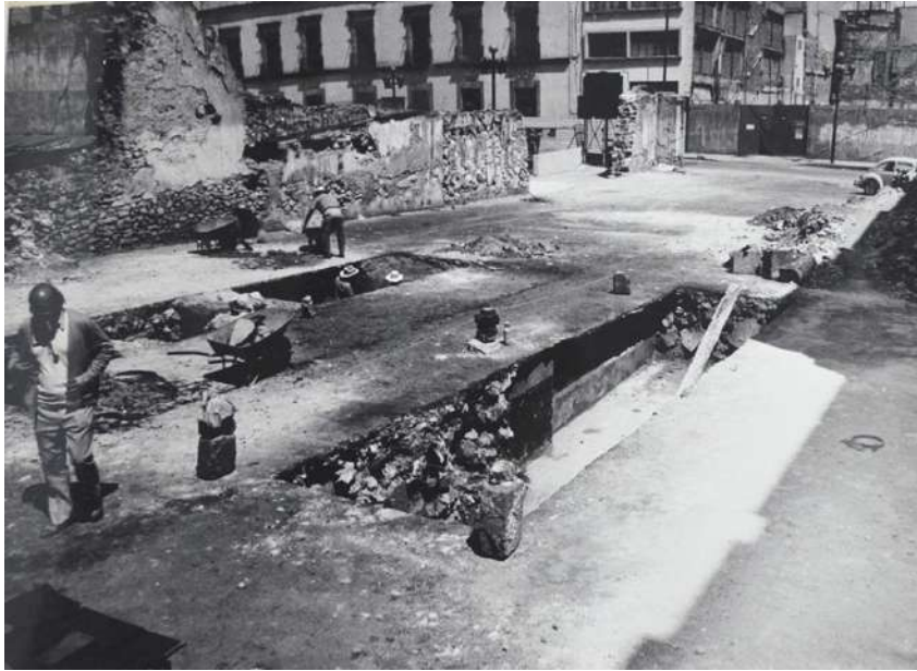
Inicio de la excavación con las tres calas iniciales, marzo 1978., Templo Mayor, exp. 32-1.
