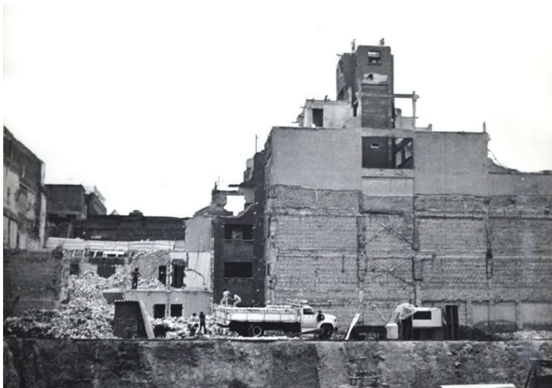
Edificio Guatemala 58. Templo Mayor, exp, 32-28 al 32-31, año 1980, Foto: [CNA].
