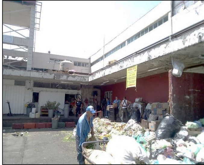
Estacionamiento al interior del mercado, usado como tiradero de basura y como espacio de venta de frutas y legumbres. Foto: Octavio Oviedo (2019).
