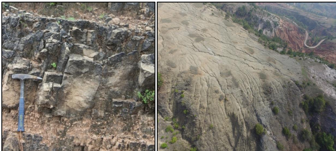
Figura 25. Andesita Yucudaac en Sta Maria Pozoltepec. (Nótese su fuerte intemperismo en pequeñas fisuras)
