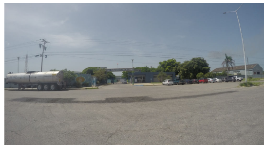
Pto. 39 Acceso a Central Termoeléctrica
