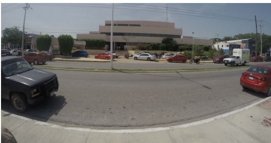
Pto. 26 Instalaciones de CFE sobre el malecón.
