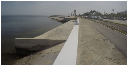
Pto. 13 Estructura de salida de drenaje pluvial próximo al monumento "Ángel Maya".
