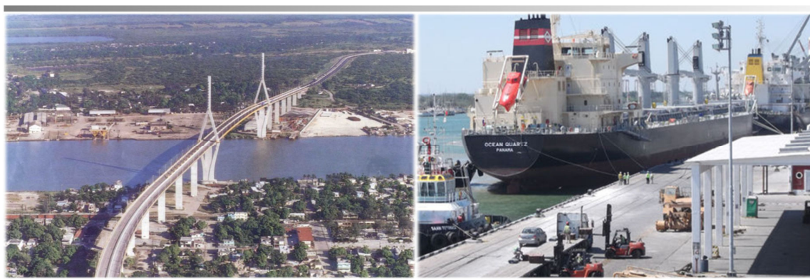
Figura 15 Tampico a la vanguardia: Puente atirantado que conecta Veracruz y Tamaulipas atravesando el río Pánuco (izquierda), y buque de carga en el Puerto de Tampico (derecha). Imágenes obtenidas de la nota Reconversión del Puerto de Tampico inicia en 2016 , generada en el sitio web milenio.com
