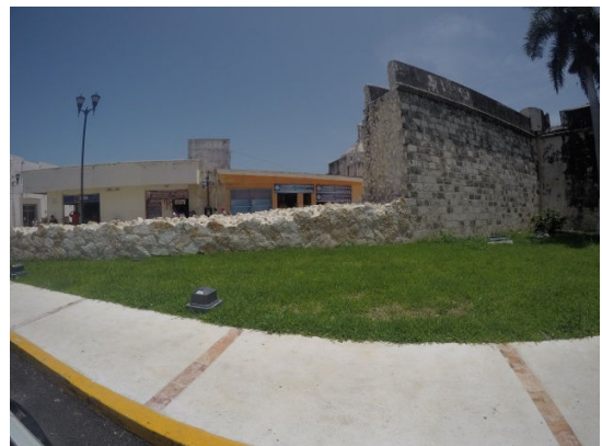
Pto. 59 Nuevas obras de restauración de la muralla de San Francisco de Campeche.
