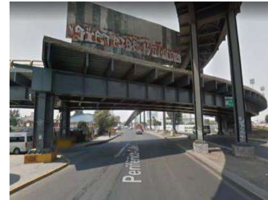
Figura 68. Anillo Periférico | Desviación Av. Río Churubusco
