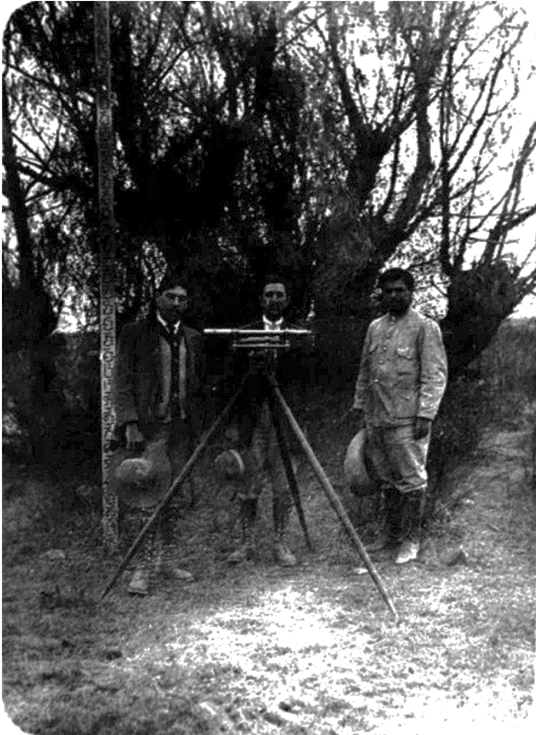
Ilustración 1. El instrumento característico de los topógrafos es el teodolito, con el cual median los terrenos. En la foto se encuentran tres ingenieros con el mencionado instrumento enfrente de ellos. Fuente: "Ingenieros topógrafos con equipo en un apareje, Ciudad de México, ca. 1905", Fototeca Nacional.
