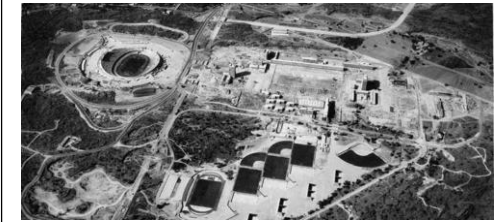
Figura 16. Panorámica de Construcción. 1952.
