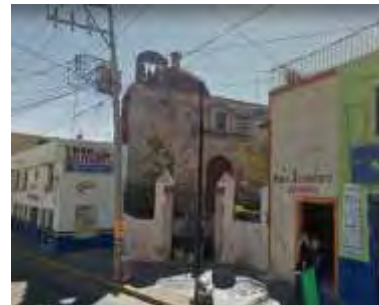
Imagen 16. Vista del Templo desde la calle Miguel Hidalgo
