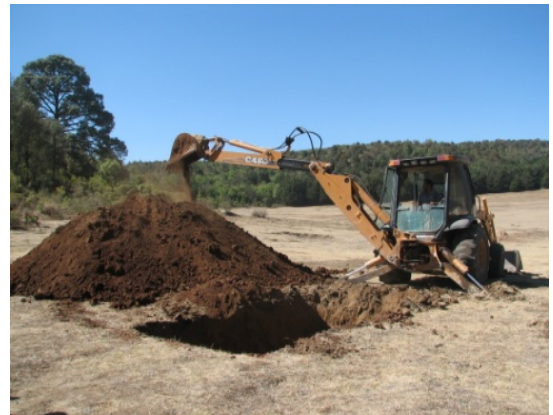
Figura 11: Fotografía de la excavación de la Trinchera
