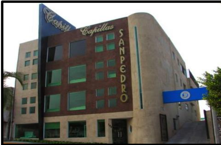
Fachada Principal de Capillas San Pedro por la parte trasera cuenta con el estacionamiento
