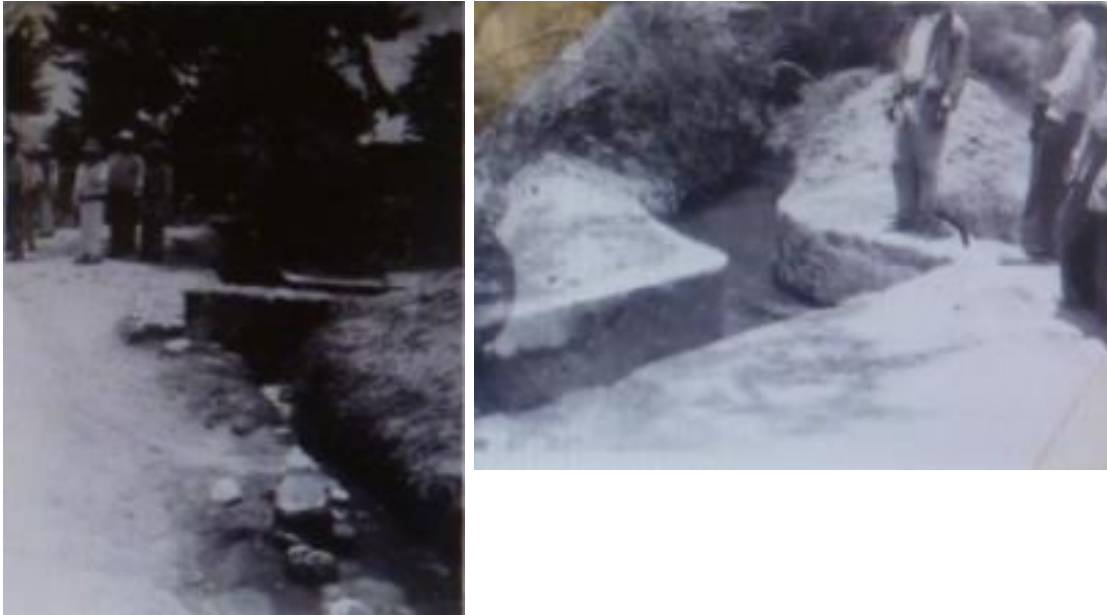
Figura 42. Comienzo de la construcción del partidor ventanas para sustituir la distribución hecha por medio de la oquedad de la época colonial (figura 7). Fuente: Fotografía tomada por el ingeniero Daniel Macías en 1928 para su informe reglamentario con el fin de modernizar la infraestructura hidráulica en el siglo XX. (AHA, A/N, Caja 798, Exp. 9719, fs. 17 y 18).
