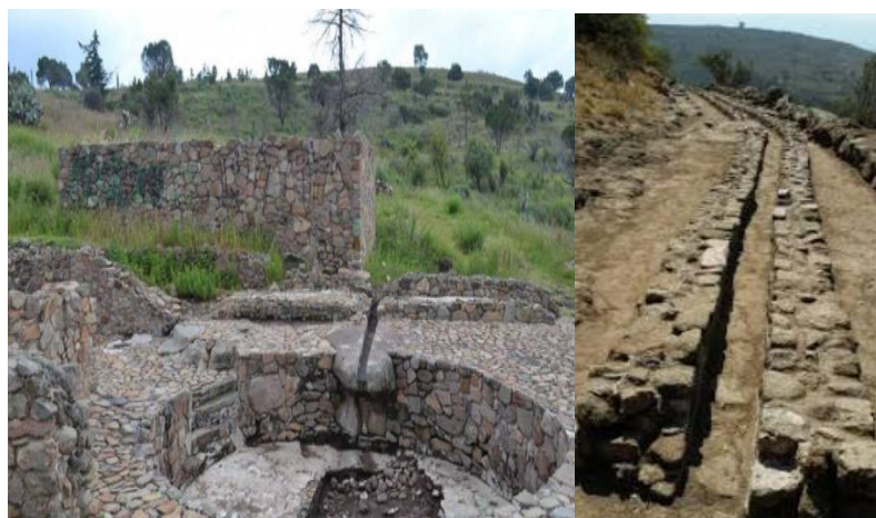
Figuras 33. Sistema de canales. Fuente: archivo propio [14 de abril de 2017].
