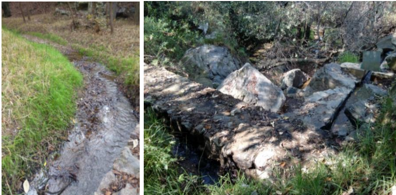
Figura 51. Los surcos de tierra llegan a la presa de desviación por el lado derecho entra el agua y recorren toda la longitud de la presa. Fuente: Archivo propio [16 de noviembre de 2019].
