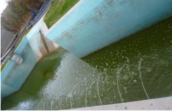
Figura 24. Estanques con clorofila y caída de agua para crear aeración. Fuente: archivo propio [11 de octubre de 2019].
