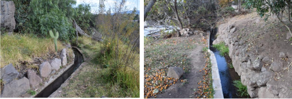
Figura 53. Canales para distribuir el agua entre los diferentes socios en que atraviesa el territorio de la comunidad. Fuente: archivo propio [3 de enero de 2019].
