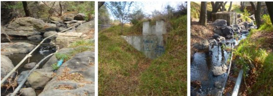
Figura 6. Manantial Palmilla conformado por tres diferentes ojos de agua que se ubican en la vertiente izquierda y se encuentran entubados para que no fluyan naturalmente al río Coxcacuaco. Fuente: archivo propio [16 de febrero de 2019].
