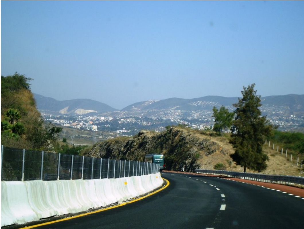
Figura 58. Ejemplo de separación de sentidos por medio de barreras New Jersey en la carretera México – Cuernavaca (CAPUFE, 2007).
