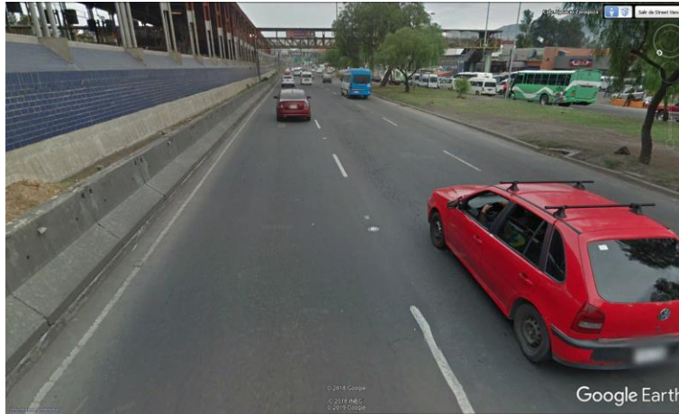
Figura 63. Evidencia de terreno disponible suficiente entre camellones (Google Earth, 2019)
