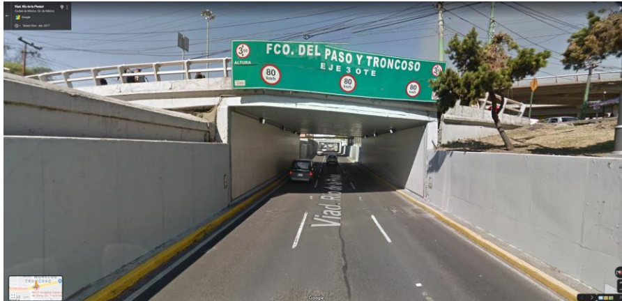
Figura 66. Intersección a desnivel presente en Viaducto Río de la Piedad (Google Maps, 2019)
