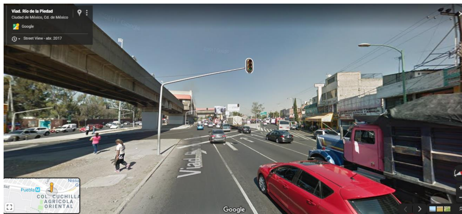
Figura 65. Intersección semaforizada al entronque Viaducto río de la Piedad con la Calzada Ignacio Zaragoza. (Google Maps, 2019).
