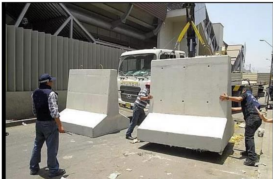
Figura 59. Barrera New Jersey de gran altura
