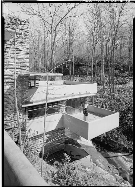
Fig. 16. Vista de las terrazas de la primera y segunda planta Library of Congress Prints and Photographs Division Washington, D.C., http://www.loc.gov/pictures/search/?q=fallingwater&co=hh
