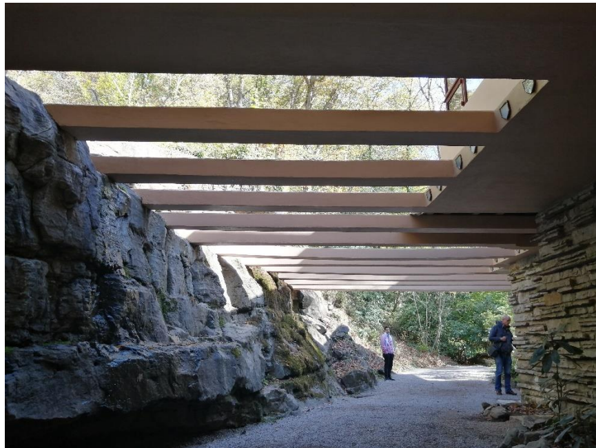
Fig. 6, 7 y 8. Vigas de reforzamiento en la fachada oeste. Tomas propias realizadas en octubre de 2019.
