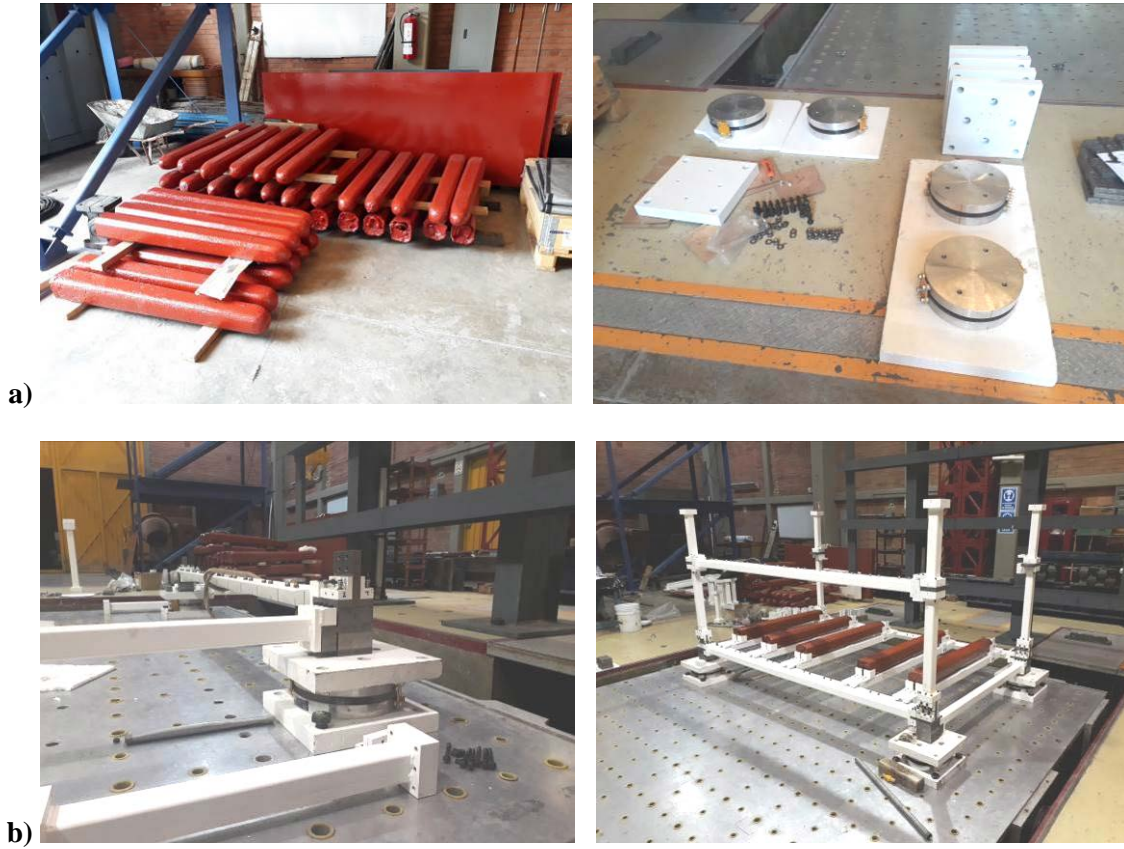
Figura 4.16. Construcción del edificio EM2-I, a) Lingotes y aisladores y b) Montaje de aisladores y primeras piezas de planta baja y nivel de aislamiento
