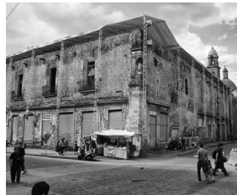
Figura 29. Larguillo fotográfico de fachada de Claustro en calle Corregidora, 2016.
