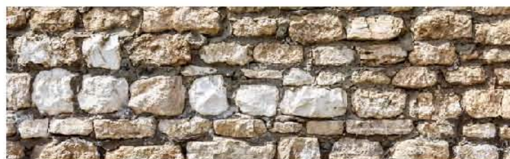
Muro de piedra consolidado con cal y arena.
