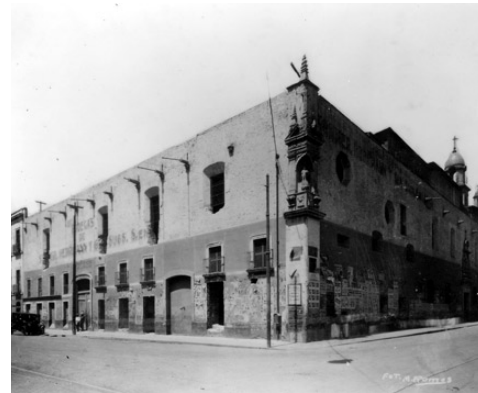
Figura 27. Larguillo fotográfico de fachada de Claustro en calle Corregidora, 2016.
