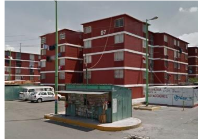
Imagen 38 Unidad Habitacional Potrero de la Laguna Universo inmueble 2020
