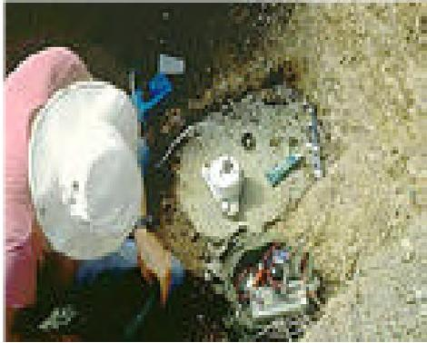
(a) Instalación de inclinómetro
