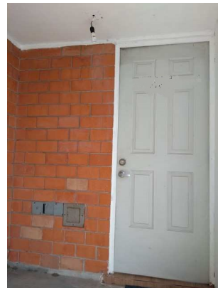
INTERIOR DEL INMUEBLE
