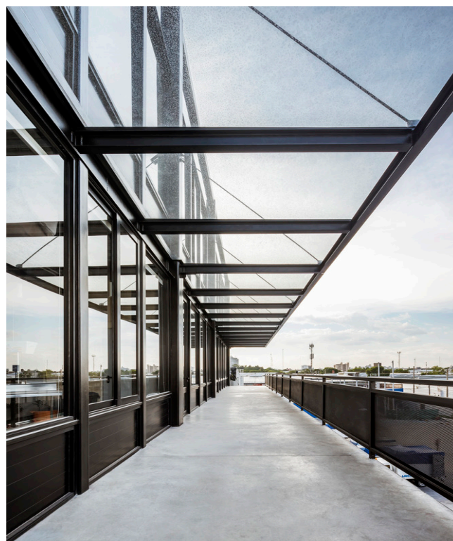
7.16 Estructura metálica del centro de distribución ABSA/FMÁSF
