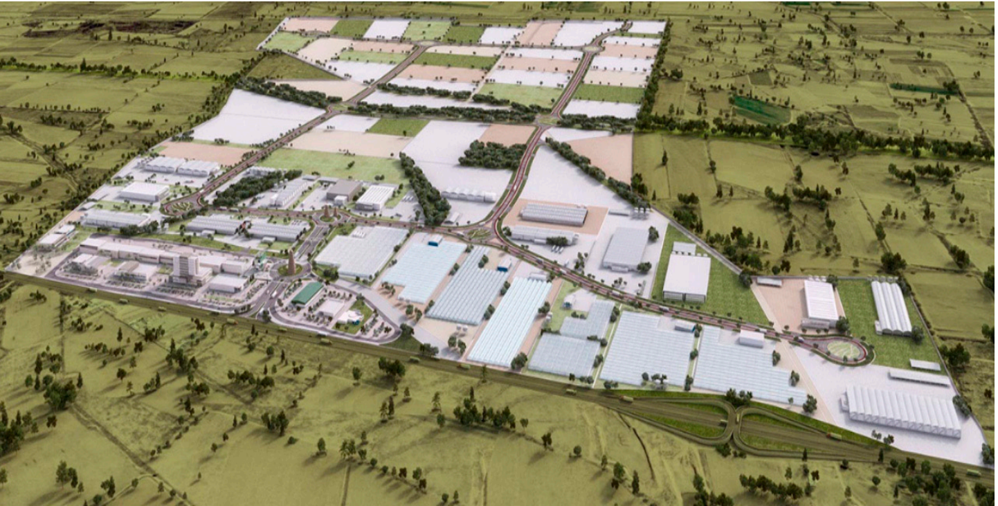
6.4 Vista general del conjunto
