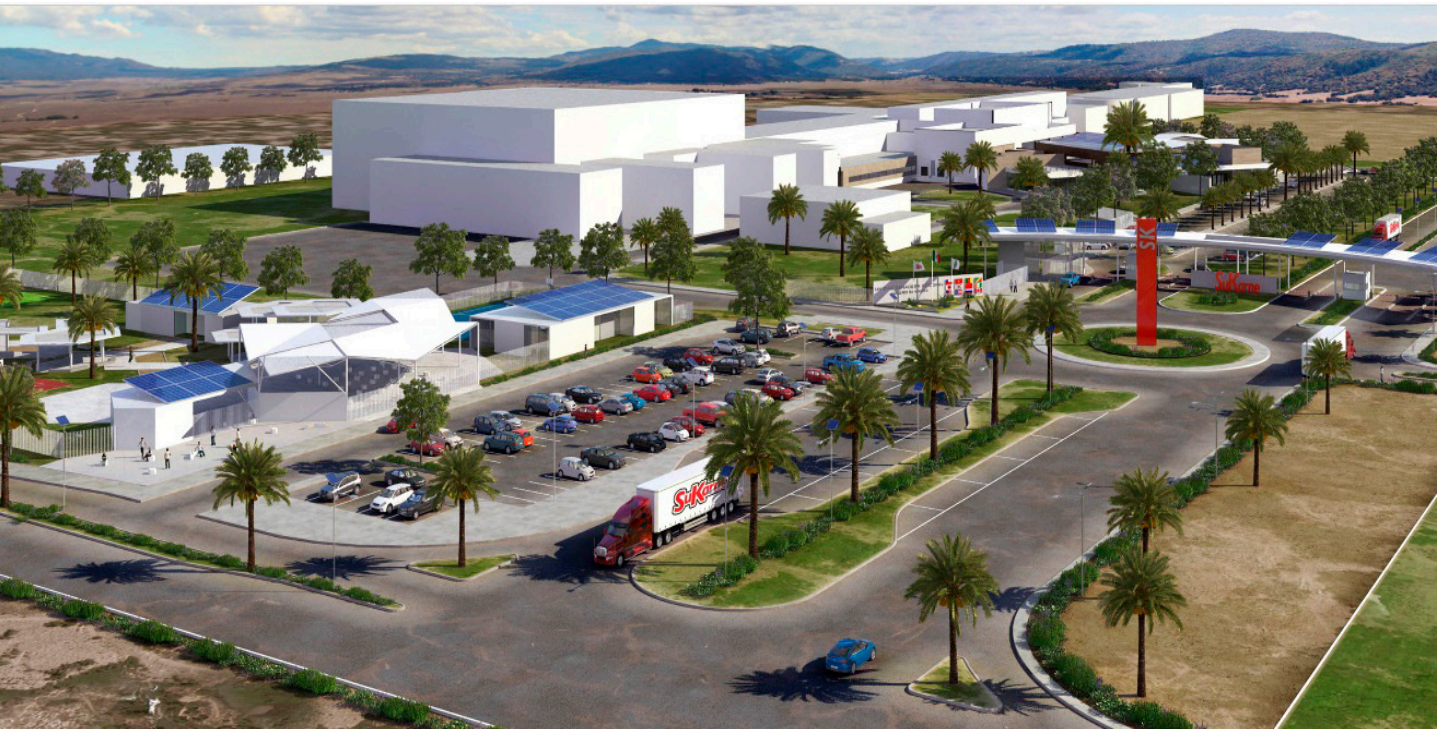
6.1 Vista general del conjunto
