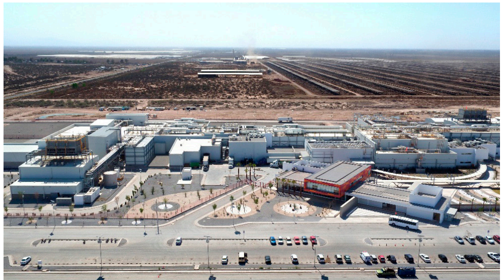
6.3 Vista lateral del conjunto casi terminado
