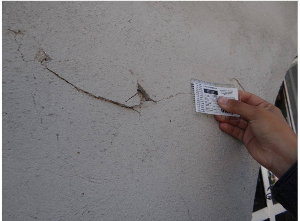
4.5 Medición de ancho y profundidad de grietas con Fisurómetro de la CMIC
