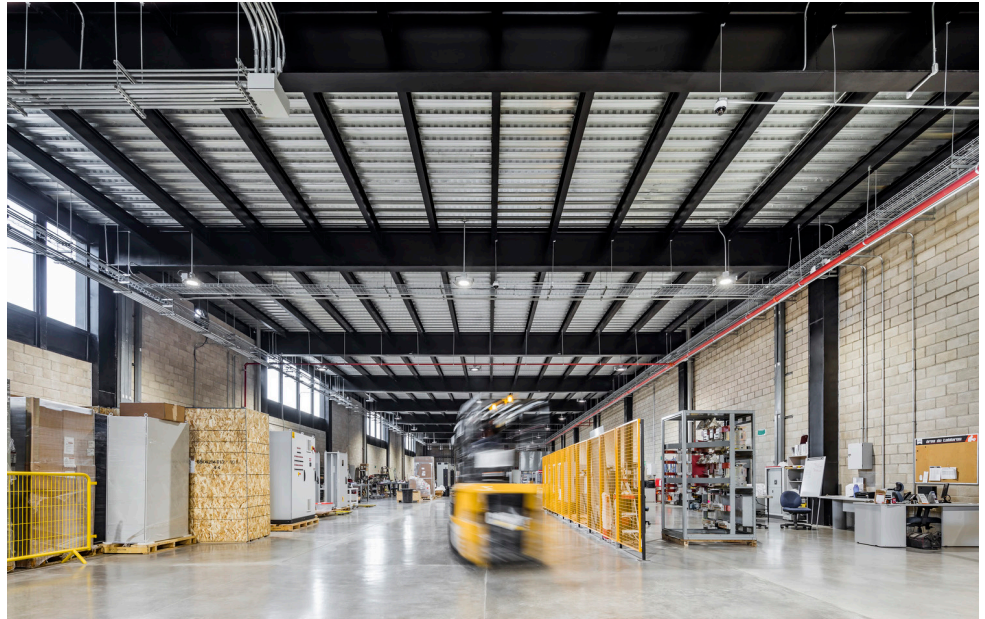
7.17 Estructura metálica interior del centro de distribución
