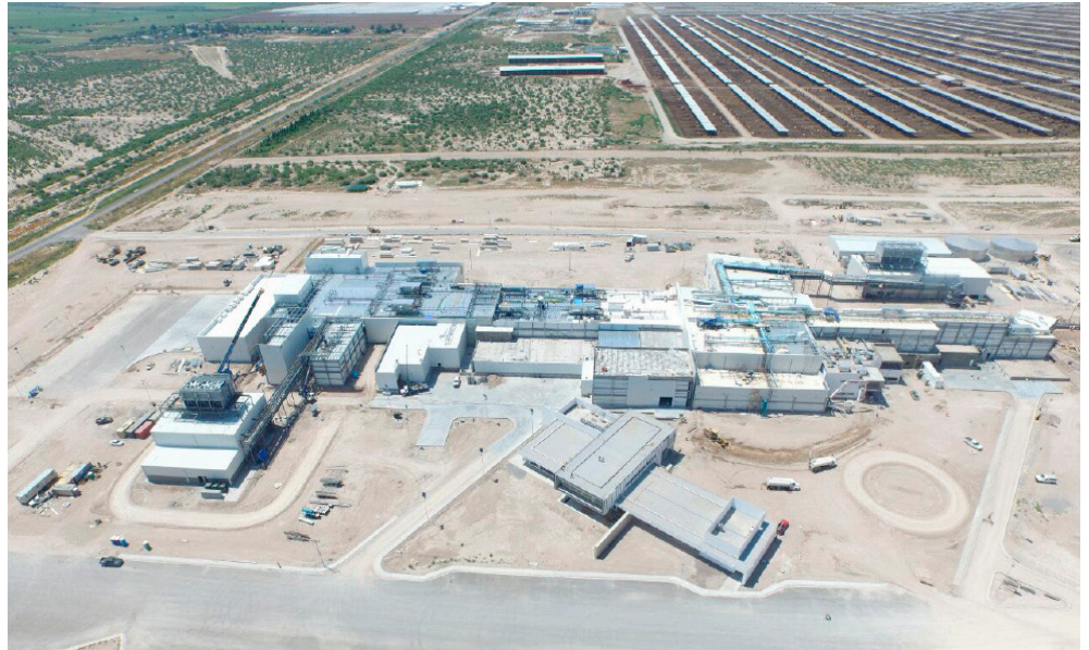
6.2 Conjunto en construcción
