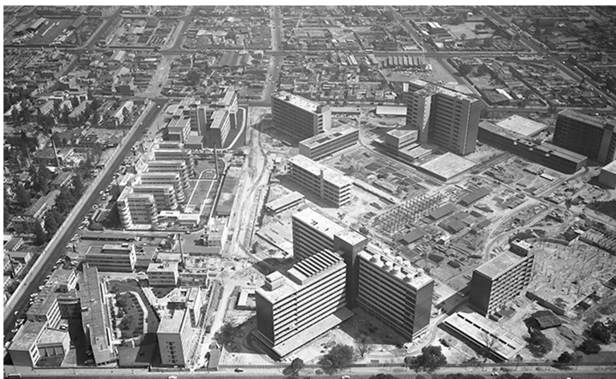
Fotos aéreas de la construcción en proceso del Centro Médico Nacional la Raza. Fundación ICA. (4 de noviembre de 1957).
