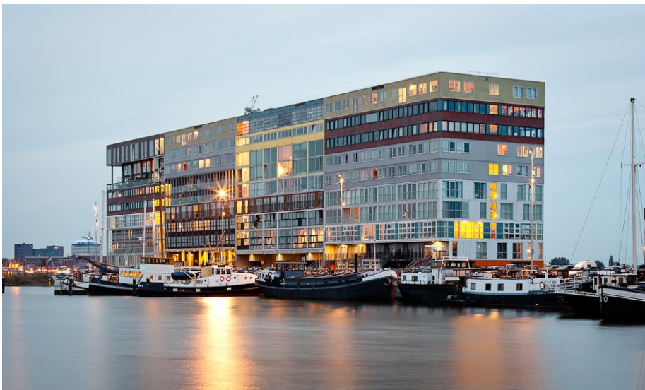
Figura 16. MVRDV (2003) Silodam. Fotografía e ilustraciones digitales.
