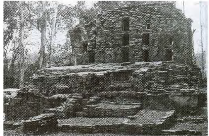
Fachada suroeste al finalizar las intervenciones (1976).
