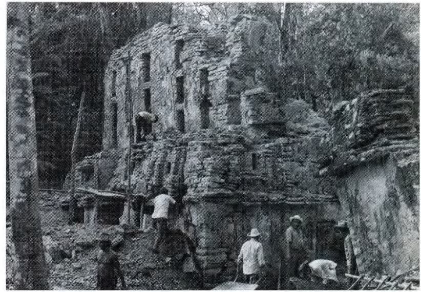
Fachadas noreste y noroeste durante los trabajos de consolidación (1976).
