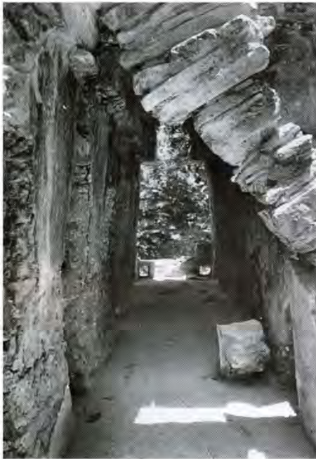
Interior de la crestería al finalizar las intervenciones (1976).
