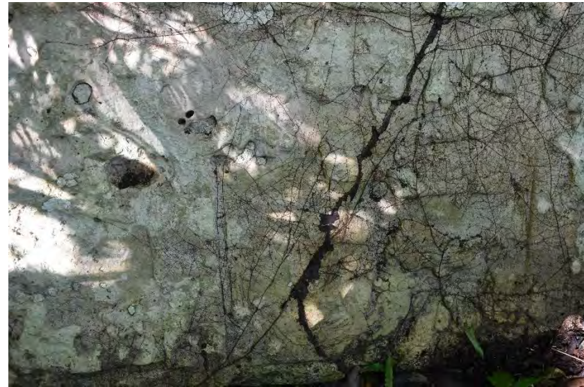
Figura 4.19 Dintel 57, Edificio 54, Yaxchilán, Chiapas. Raíces que cubren y manchan la superficie del monumento. (E. Tejeda, 2018).
