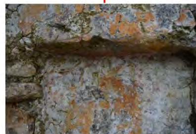
Perdida de la capa pictórica por erosión y por deterioro químico-biológico
