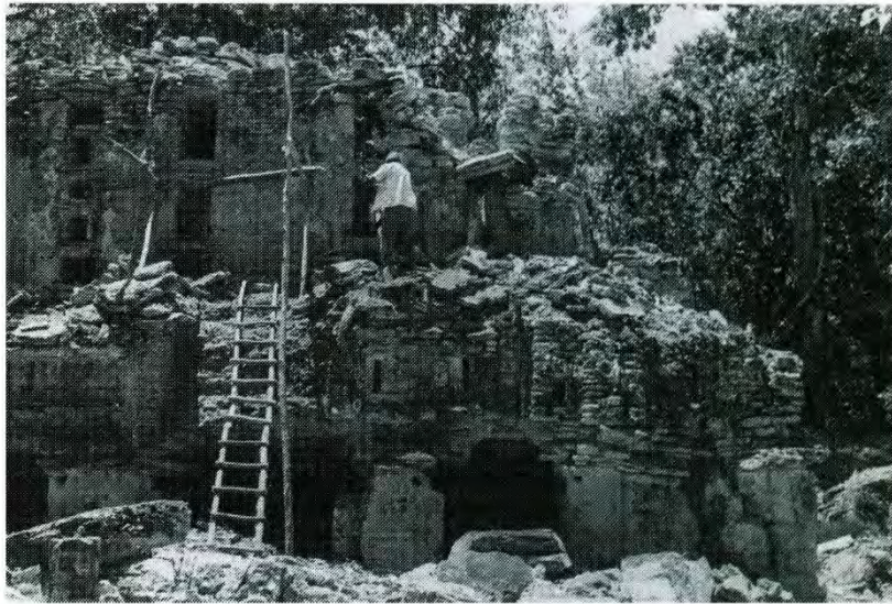
Fachada noreste durante los trabajos de consolidación (1976).
