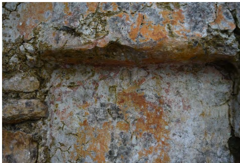
Figura 5.26 Restos de pintura anaranjada y roja en el panel central de la fachada noroeste. (E. Tejada, 2017).
