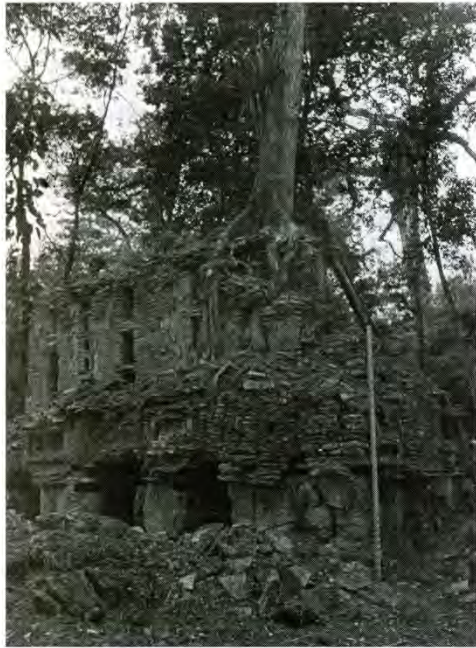
Esquina norte antes de las intervenciones (1976).
