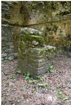
Microflora y musgos cubren el pilar. Elemento arquitectónico inclinado por colapso.
