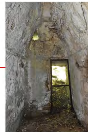
Humedad en paramento y bóveda por capilaridad, condensación y filtración, aunado a la concentración de escombros y hojarasca. Concreciones y fisuras por sales. Algas y raíces cubren muro y bóveda.
