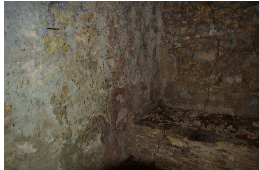
Figura 4.21 Paramento manchado por deyecciones, y acumulación de guano y semillas sobre banqueta y el suelo, Edificio 19, Yaxchilán, Chiapas. (E. Tejada, 2019).
