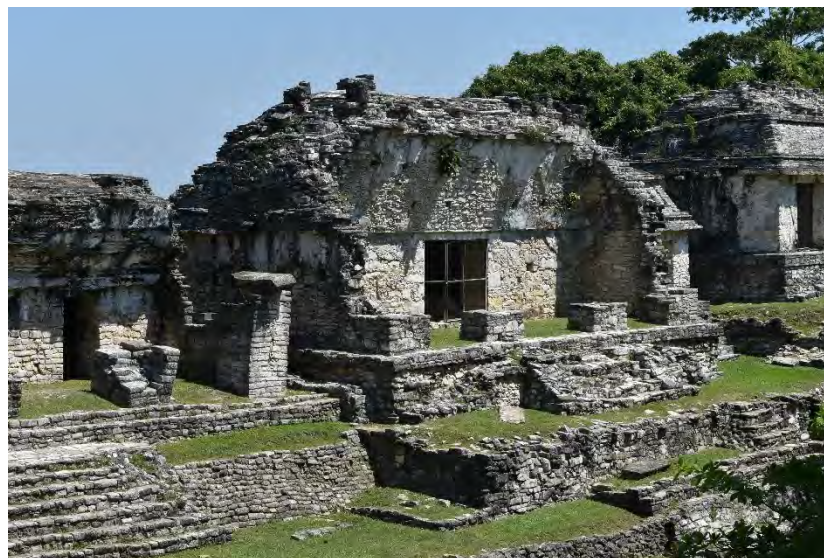
Figura 6.8 Templo IV del Grupo Norte, Palenque, Chiapas. Nótese las huellas de los morillos en la bóveda. (E. Tejeda, 2017).
