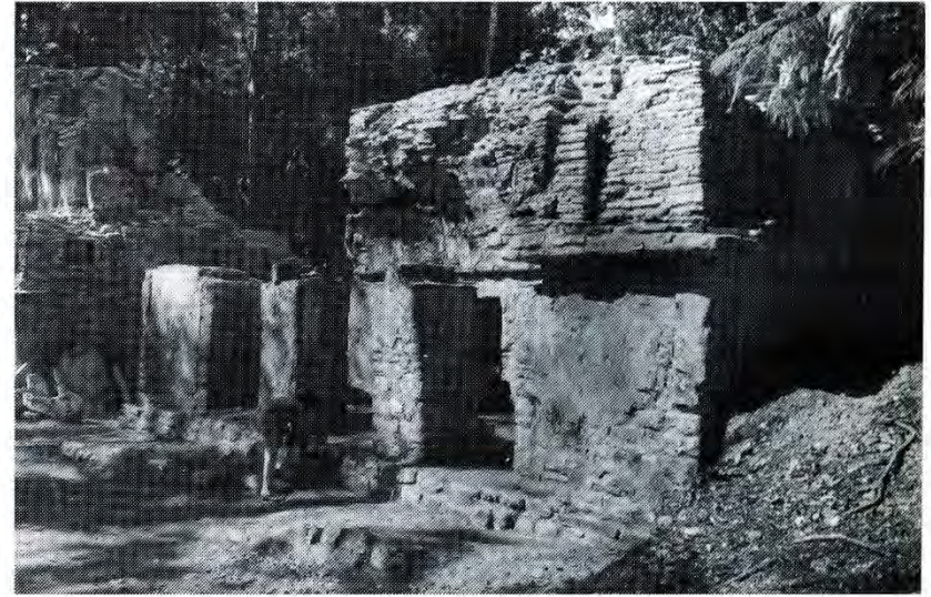
Fachada noreste y noroeste al finalizar las intervenciones (1976).
