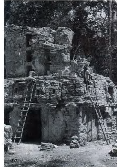
Esquina norte durante los trabajos de consolidación (1976).
