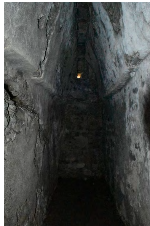
Figura 5.21 Crujía central. Es notoria la ventila vertical en la cúspide de la bóveda. (E. Tejeda, 2017).
