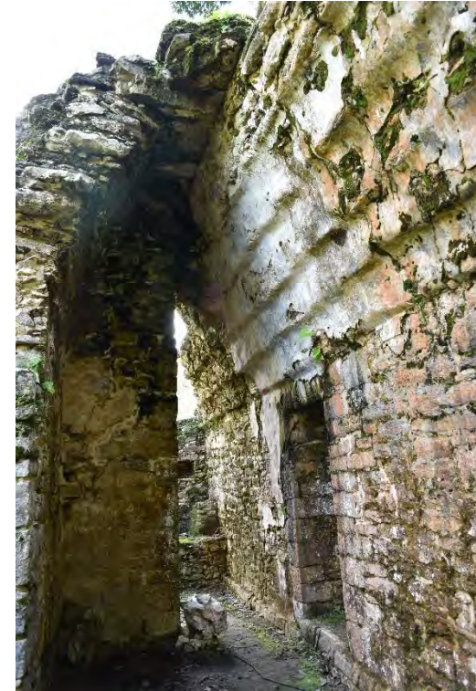
Figura 3.37 Contrafuerte al interior de una de las crujía del Edificio 23, Yaxchilán, Chiapas. (E. Tejeda, 2017).
