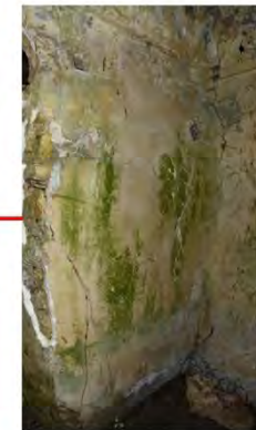
Invasión de algas en paramentos y humedad ascendente en rodapiés. Manchas por deyecciones de murciélago. Ribetes modernos en algunas lagunas.
