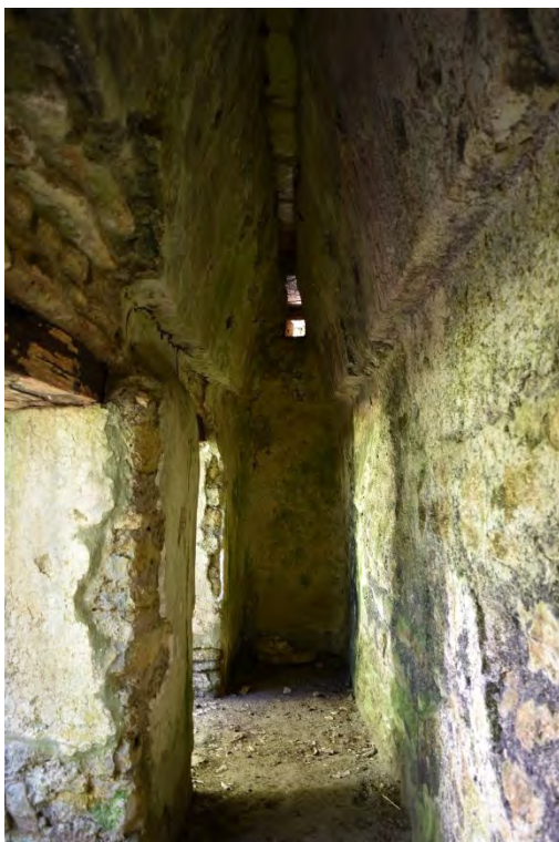
Figura 5.19 Galería noreste. Se puede apreciar la ventila en el intradós. (E. Tejeda, 2017).
