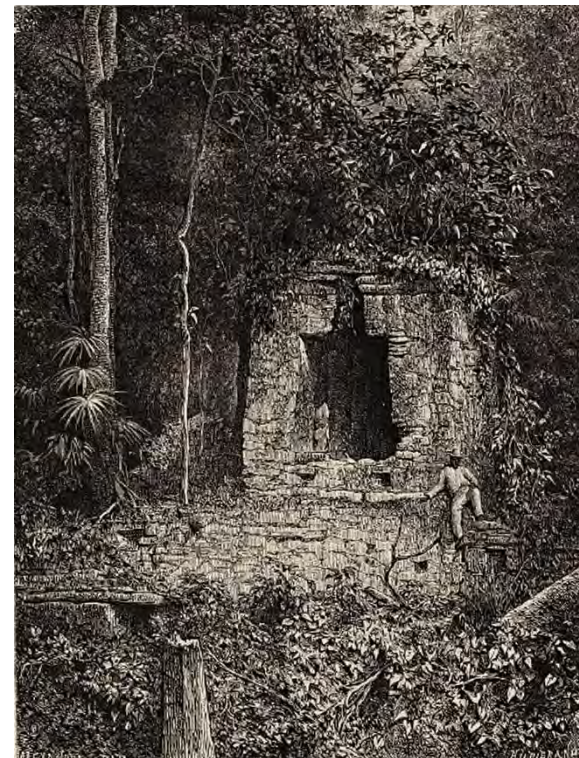
Figura 5.7 Litografía de la crestería del Edificio 6, fachada sureste. (Charnay, 1885).
