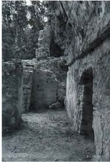
Crujía noreste al finalizar las intervenciones (1976).
