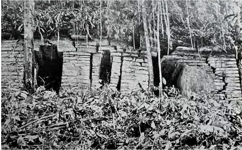
Figura 3.36 Contrafuerte en uno de los vanos de un templo de Oxlahuntún, Chiapas. (Healey, 1948).
