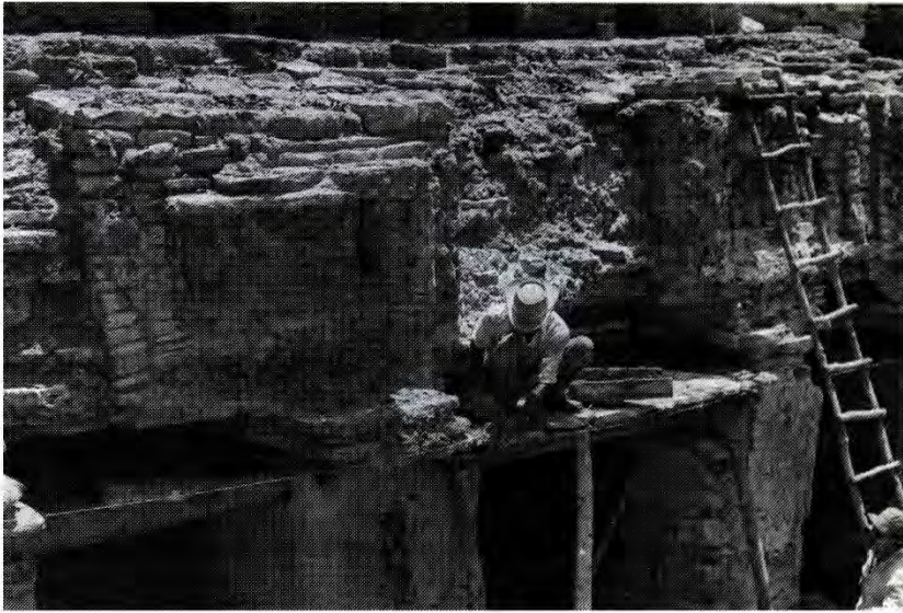
Restitución de los dinteles de la fachada noreste (1976).
