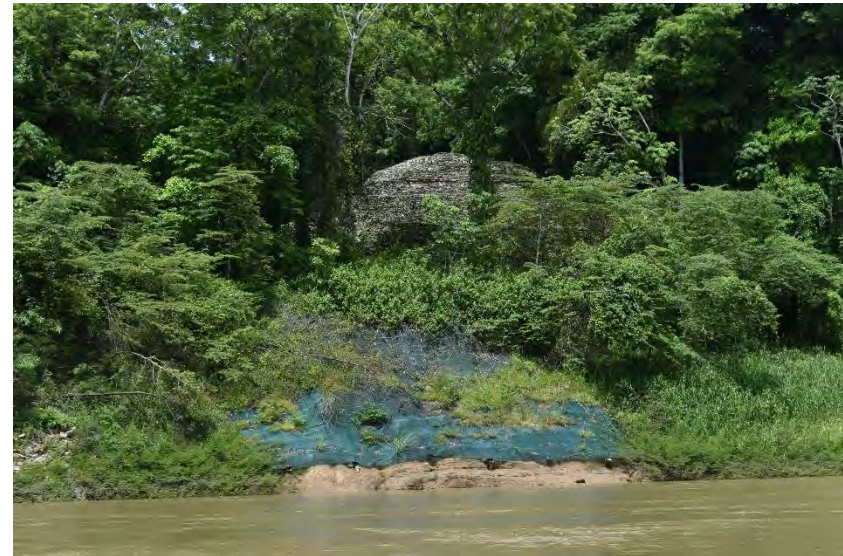
Figura 4.11 Gavión de concreto erosionado, Yaxchilán, Chiapas. En segundo plano se observa el Edificio 18. (E. Tejeda, 2018).
