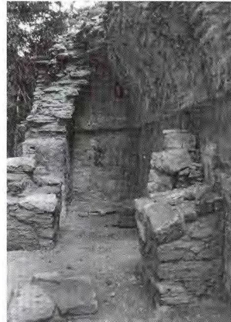
Crujía suroeste al finalizar las intervenciones (1976).
