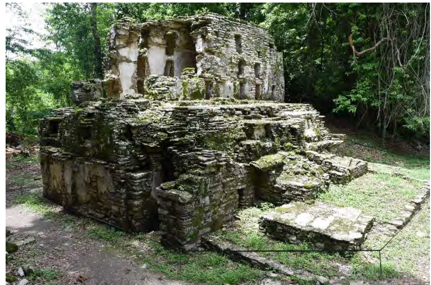
Figura 5.18 Fachadas noroeste y suroeste. Al extremo derecho se observa la plataforma habitacional y las banquetas que se adosaron. Y en primer plano la caja de piedra que protege el trono 2. (E. Tejeda, 2017).
