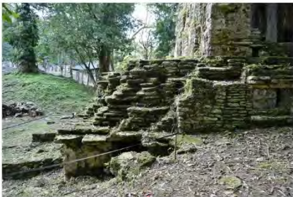
Humedad por capilaridad en rodapiés
