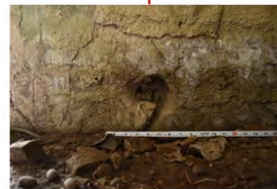
Argolla del sujetador perdida.
