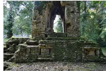
Vegetación cubre casi en su totalidad la fachada Desintegración severa del recubrimiento de estuco de la crestería
