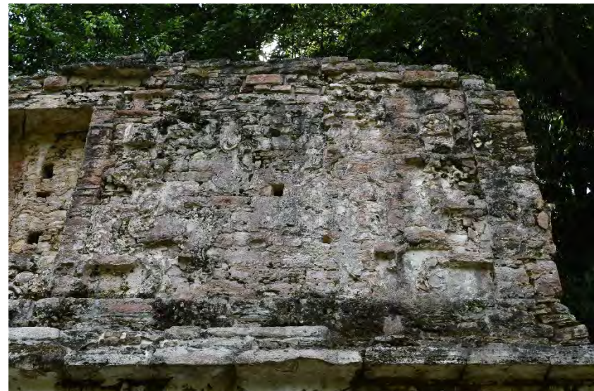
Figura 4.12 Detalle del friso del Edificio 20, Yaxchilán, Chiapas. Se percibe la pérdida casi total de los relieves de estuco. (E. Tejeda, 2018).
