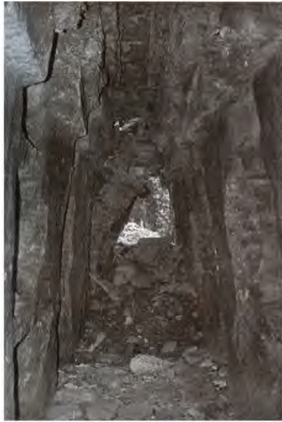
Interior de la crestería antes de las intervenciones (1976).
