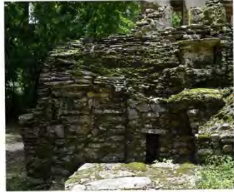
Toda la fachada está cubierta por microflora y vegetación
