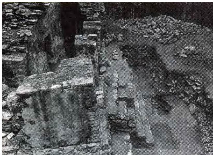
Figura 5.32 Subestructura del Edificio 7, fachada noreste. (García, 2003).
