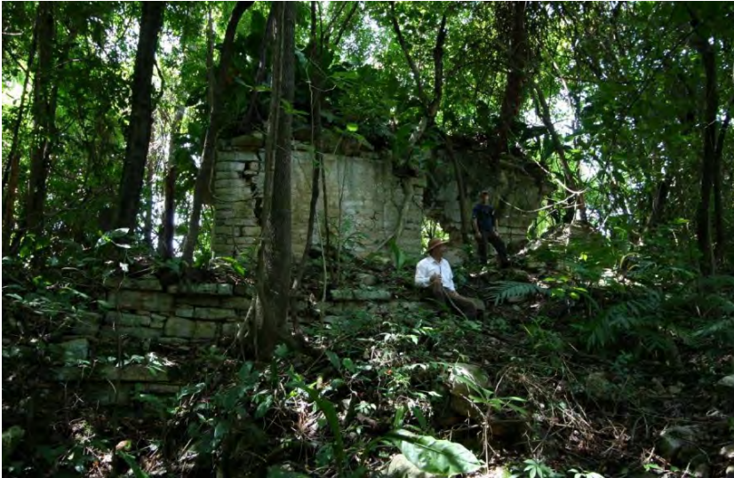
Figura 6.3 Fachada suroeste de la Estructura D6-1, Budsilhá, Chiapas. (Golden y Scherer, 2011).
