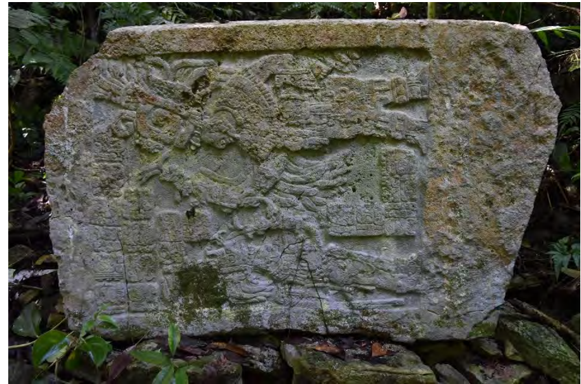
Figura 4.17 Dintel 52, Edificio 55, Yaxchilán, Chiapas. Proliferación de algas por capilaridad ascendente. (E. Tejeda, 2018).
