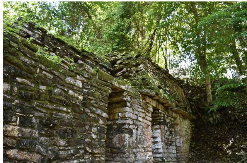
Figura 4.16 Edificio 25, Yaxchilán, Chiapas. Superficie completamente cubierta por algas, líquenes y musgos. (E. Tejeda, 2018).
