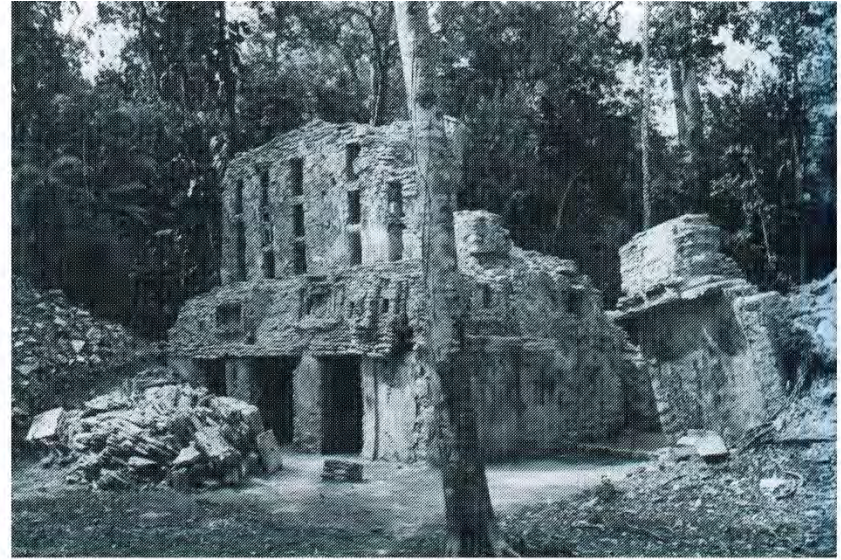
Fachadas noreste y noroeste al finalizar las intervenciones (1976).
