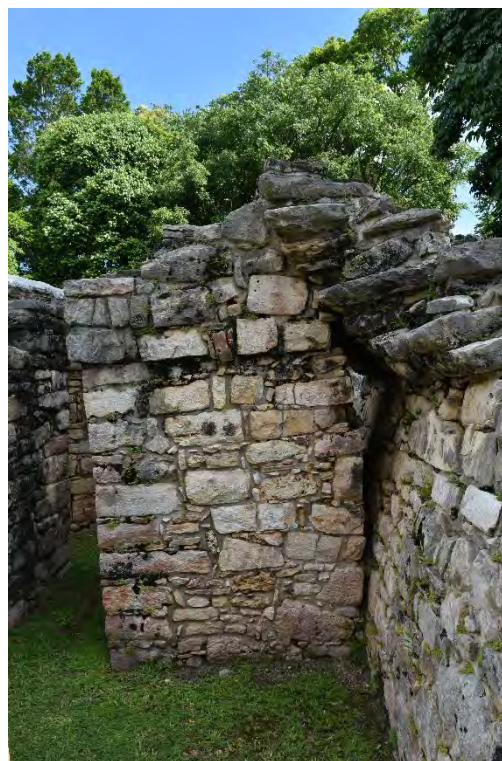
Figura 4.24 Contrafuerte para contrarrestar el coceo de la bóveda, Edificio 42, Yaxchilán, Chiapas. (E. Tejeda, 2018).
