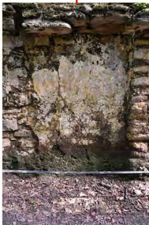
Humedad por capilaridad ascendente en el rodapié y proliferación de algas y musgo
