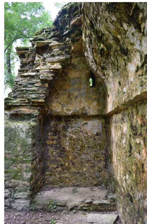
Figura 5.40 Extremo norte de la galería suroeste. En la base hay una banqueta. (E. Tejada, 2017).
