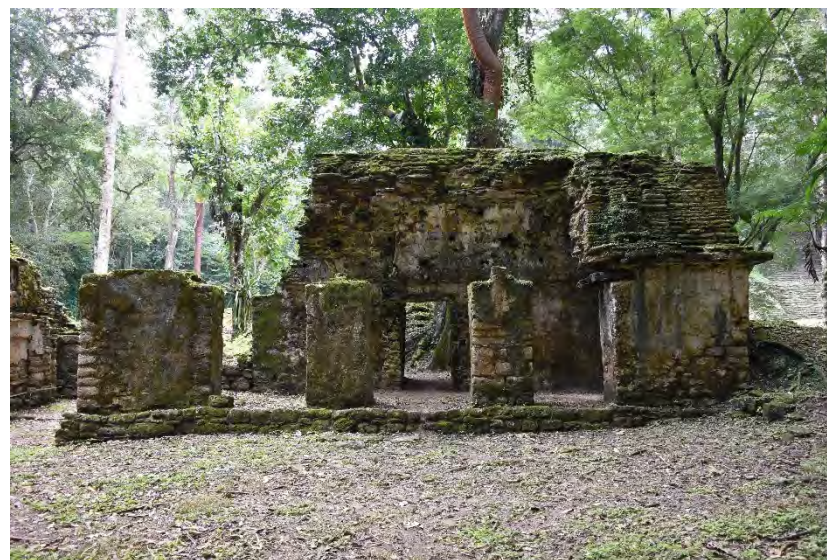
Figura 5.33 Fachada noreste. (E. Tejada, 2017).
