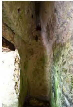
Humedad en lienzo y bóveda por condensación y capilaridad ascendente. Agrietamiento por migración de sales. Invasión de microflora. Manchas por deyecciones de murciélago.
