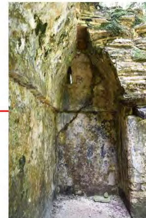
Humedad por capilaridad ascendente en el rodapié. Disgregación en el recubrimiento por deterioro bioquímico. Algas que cubren paramento e intradós de la bóveda. Manchas por deyecciones de murciélago. Se aprecia la marca de una banqueta desmantelada durante la época prehispánica. La grieta fue resanada con una mezcla de cal y una resina como aditivo, queha sufrido oscurecimiento y exuda residuos que manchan el paramento.
