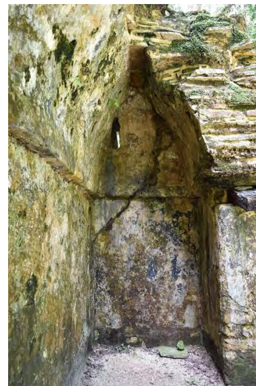
Figura 5.38 Extremo norte de la galería noreste. En la base se percibe la huella de la banqueteta desmantelada. (E. Tejada, 2017).
