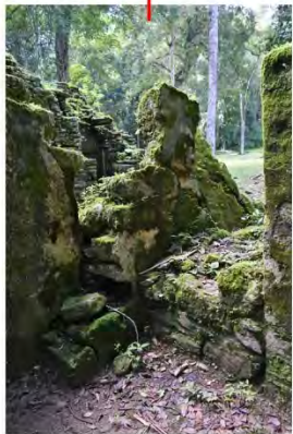
Fragmento del tapial que cegaba el vano sureste del muro central.
