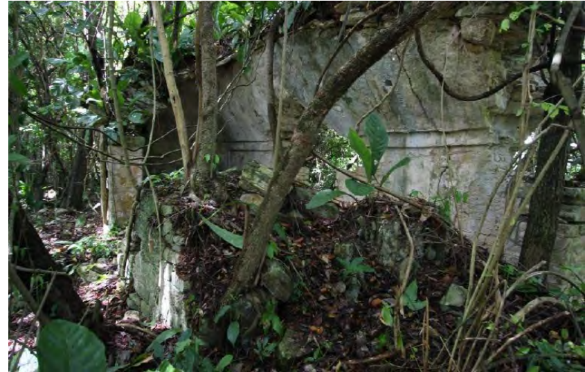
Figura 6.4 Galería noreste de la Estructura D6-1, Budsilhá, Chiapas. (Golden y Scherer, 2011).
