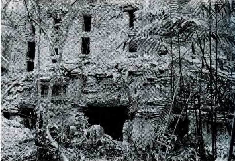
Fachada noreste antes de las intervenciones (1976).
