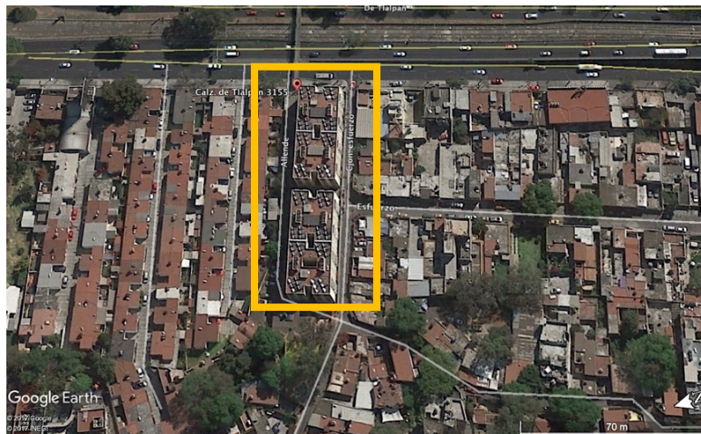
Figura 22a. El Unidad habitacional terminada.
