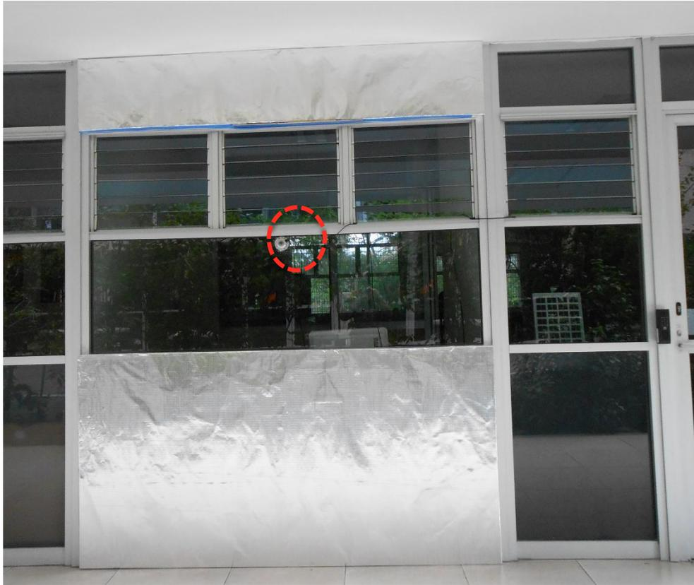
Figura 4- 16 / Fachada del Cubículo y conformación del 35% WWR. Comprobación de modelos. Ubicación del piranómetro para la medición de la Irradiancia global Vertical.
