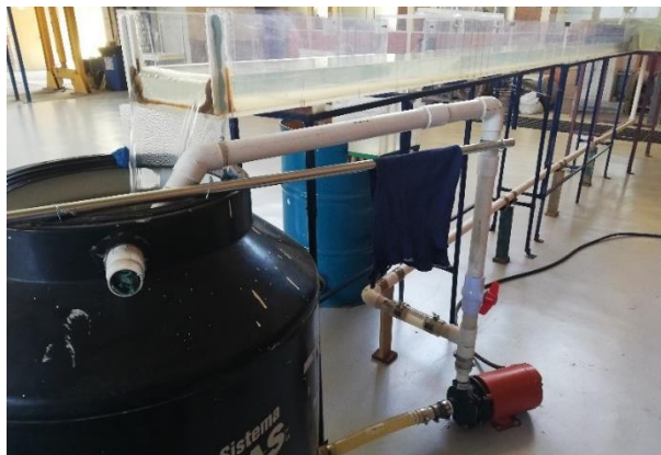
FIGURA 3.18 Equipo de bombeo y la red de recirculación.
