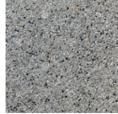
Piso de concreto lavado como acabado final en bodegas
