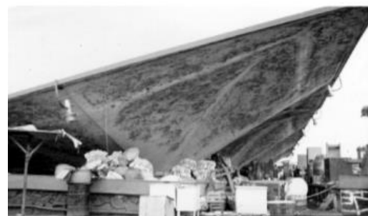
Imagen 14: La nave tres colapsada en el terremoto de 1985 . Fuente: Historia de un mercado. Jamaica vive.
