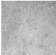
Piso de concreto hidráulico en exteriores
