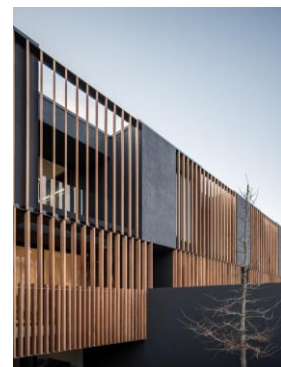
Doble fachada hecha de paneles
