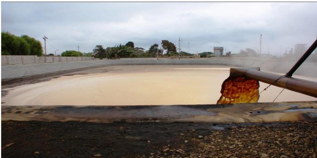
**Imagen 20. Tratamiento de vinaza para producir biogas. Debido a las características de la vinaza, por cada 100 m<sup>3</sup> de esta, un biodigestor puede producir un estimado de 3,000 m<sup>3</sup> de biogás. Foto tomada de [www.aqualimpia.com](http://www.aqualimpia.com)**
