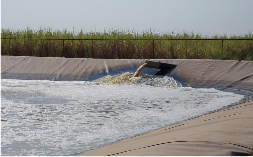
**Imagen 2. Lagunas artificiales creadas para la oxidación y tratamiento de las vinazas. Foto tomada del Portal Caña.**
