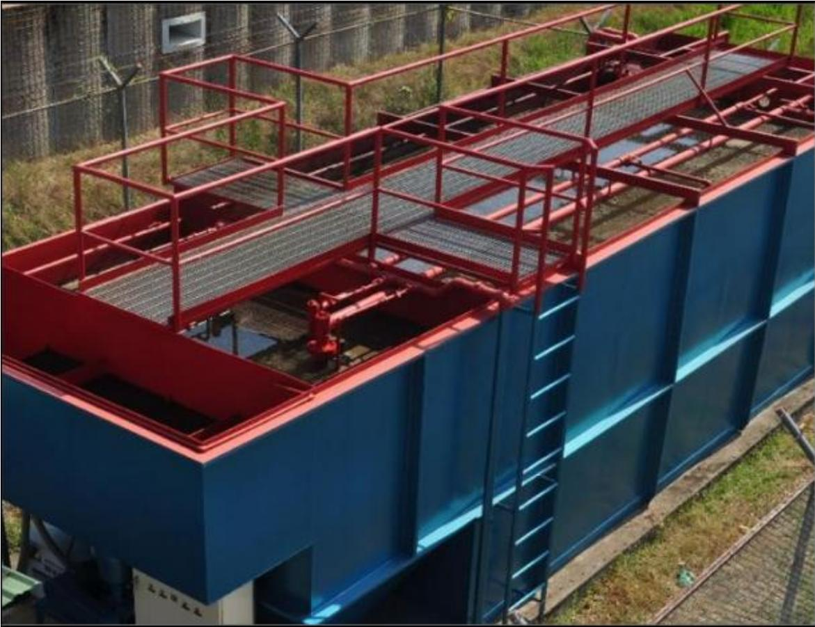
**Imagen 11. Planta de tratamiento de aguas residuales sanitarias, sistema de aireación extendida y tratamiento mediante lodos activados (Bacterias aerobias). Foto tomada de Diseños y Construcciones Industriales S.A.**
