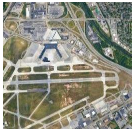
Aeropuerto de Seattle, cuya construcción fue hecha con paneles estructurales
