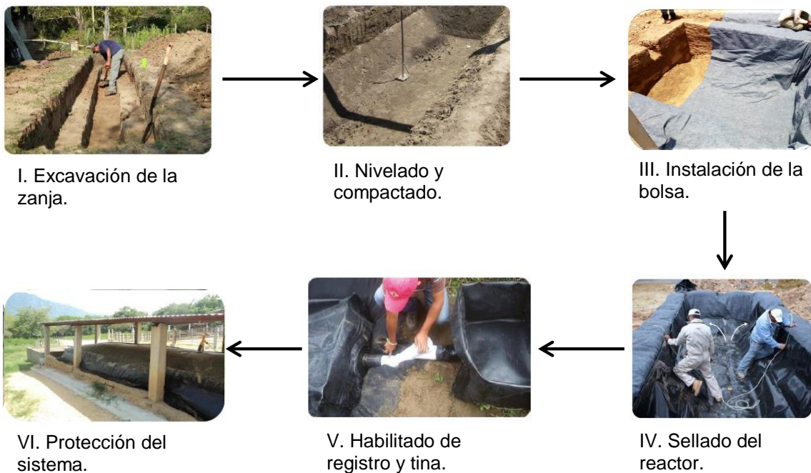
Figura 4.13 Proceso de instalación del biodigestor.
