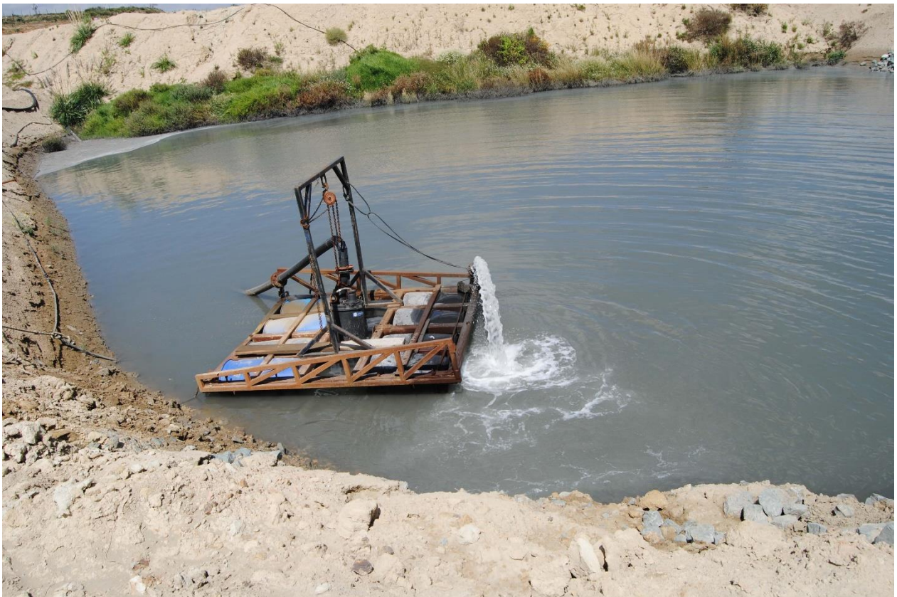
Figura 4.8. Aparato para recircular el agua desde el depósito de jales hacia los procesos mineros mediante una bomba y una tubería en la unidad minera Vetagrande, Zacatecas.
