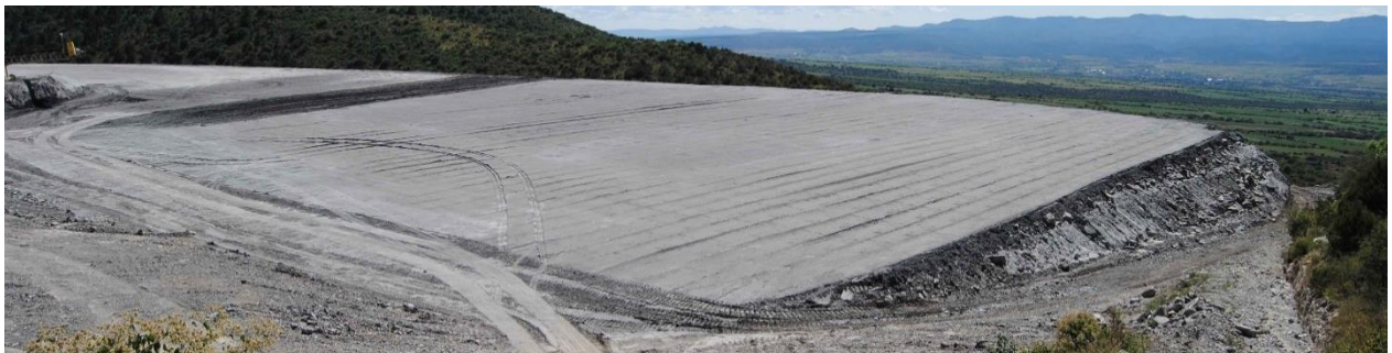
Figura 4.5. Depósito de jales seco en la unidad minera Del Toro en Chalchihuites, Zacatecas.
