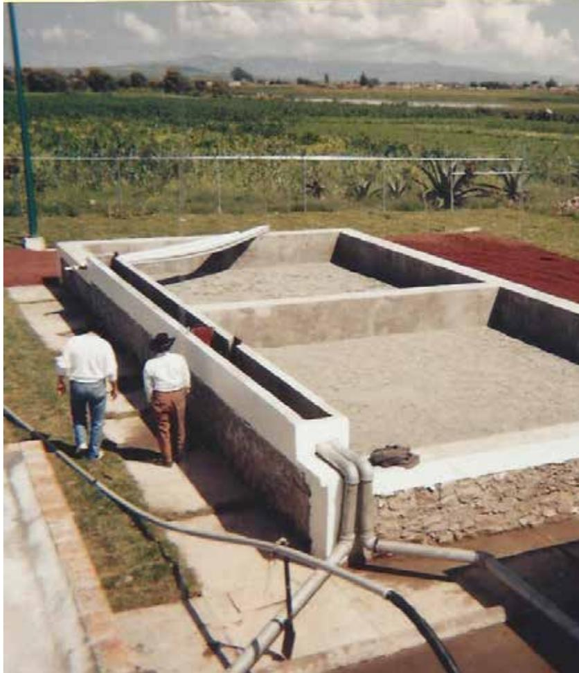
Foto 1. Lechos de Secado en Planta de tratamiento en Napateco.
