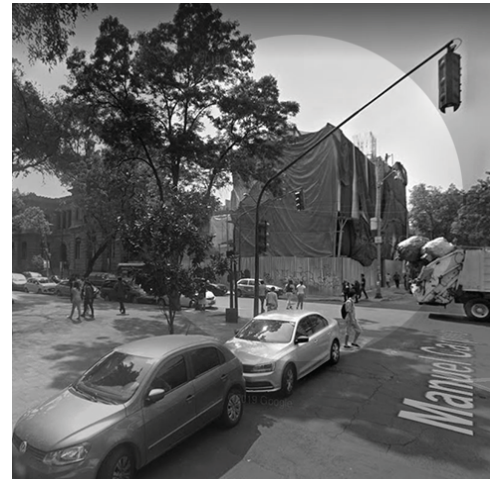
Imagen 12. Vista del predio
