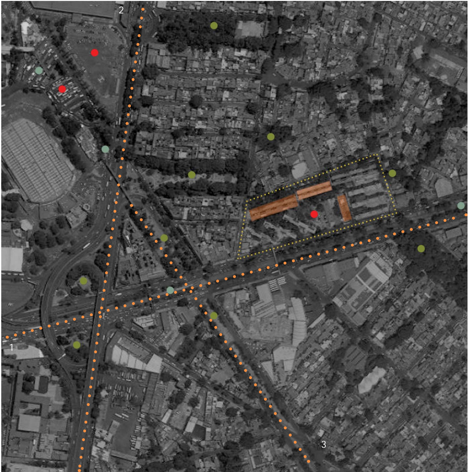
Imagen 92. Localización del predio ubicado en Calzada de Tlalpan S/N, Col Educación, Alcaldía Coyoacán.
