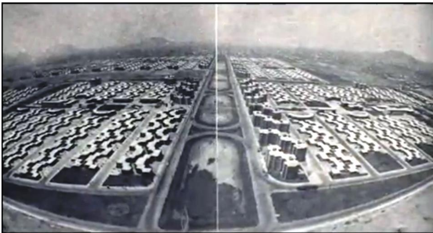
Unidad habitacional en construcción en los años setentas.
