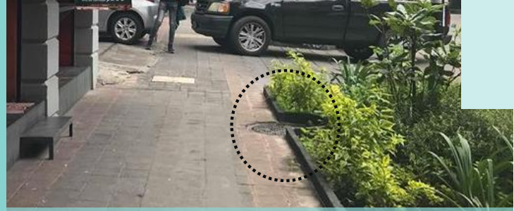
Imagen 15. Registro eléctrico en banqueta sobre Av. Versailles. Elaboración propia.
