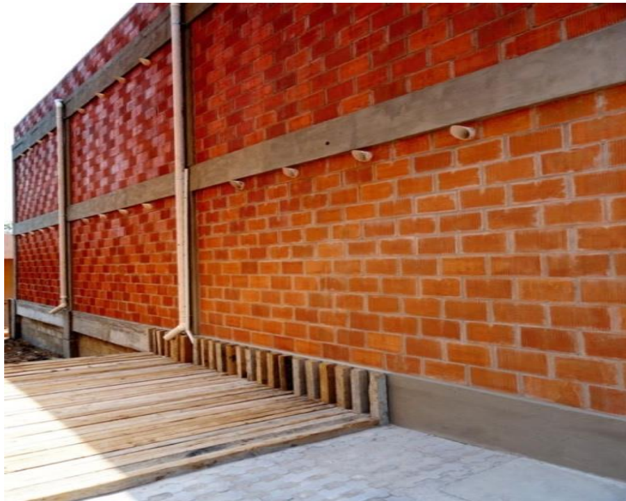
Figura 13: Sistema de ventilación natural
