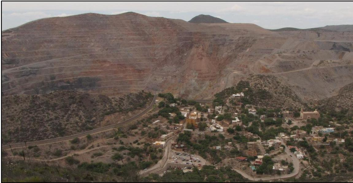
*Figura 3: Aspecto de la mina a cielo abierto en Cerro de San Pedro, San Luis Potosí, la cual removió una montaña completa durante el transcurso de 10 años de trabajos de minería a tajo abierto. Fotografía del autor, mayo 2018.*
