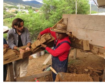
Construcción de bóveda
