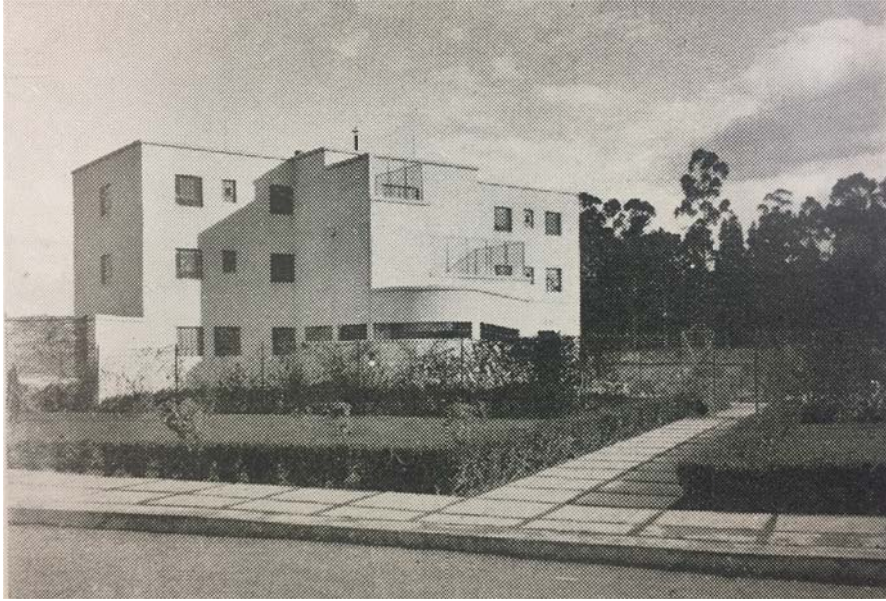
Pabellón No. 1 Vista desde la entrada principal 372
