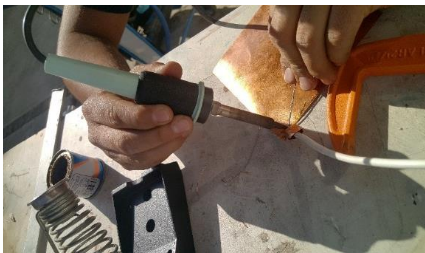
Fotografía 11. Unión de placa y cable con soldadura de estaño
