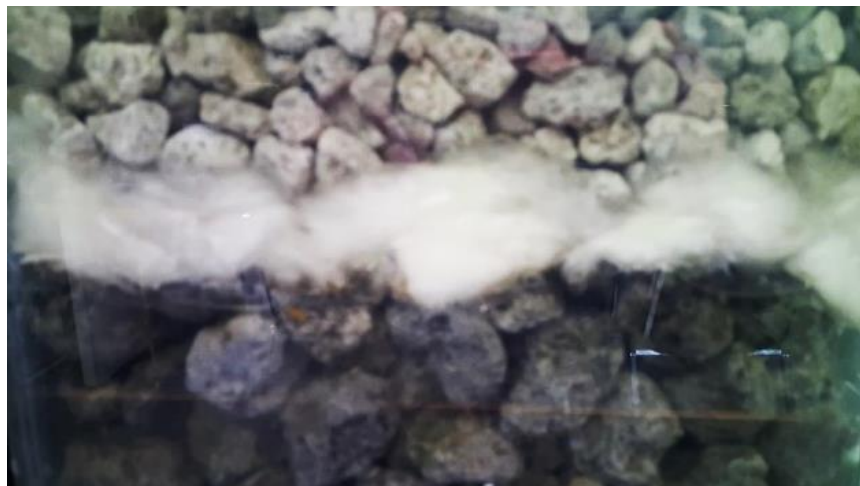
Fotografía 15. Membrana de fibra de vidrio colocada en el Humedal.
