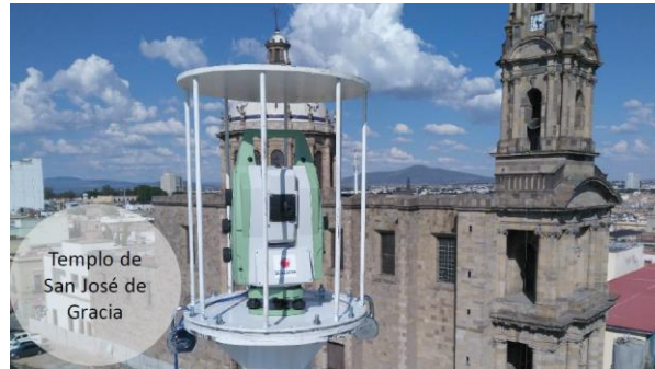
Figura 54. Vista del Templo de San José durante el monitoreo. Fuente: LYTSA.
