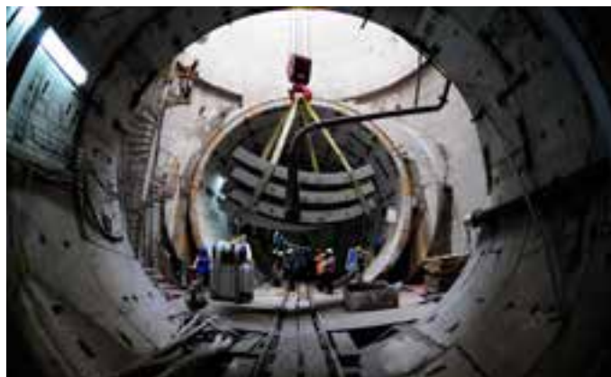
Figura 3.21 - Túnel Emisor Oriente (TEO), 2016.
