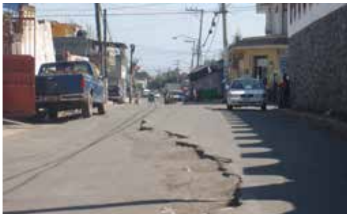
Figura 6.26 - Hundimientos diferenciales en el centro de Mixquic.
