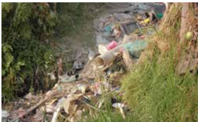
Figura 8.2.20 - Borde de canal utilizado como basurero y drenaje.
