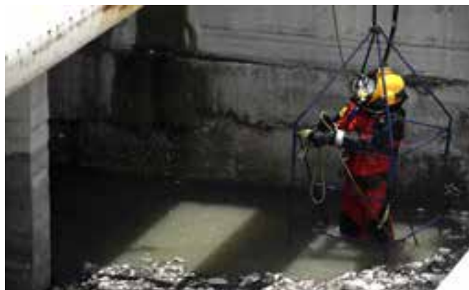
Figura 3.20 - Buzo de aguas negras en el Gran Canal de Desagüe, 2010.
