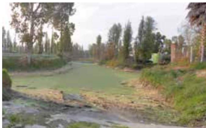
Figura 8.2.13 - Estado actual del canal y rampa de embarcadero en época de estiaje.
