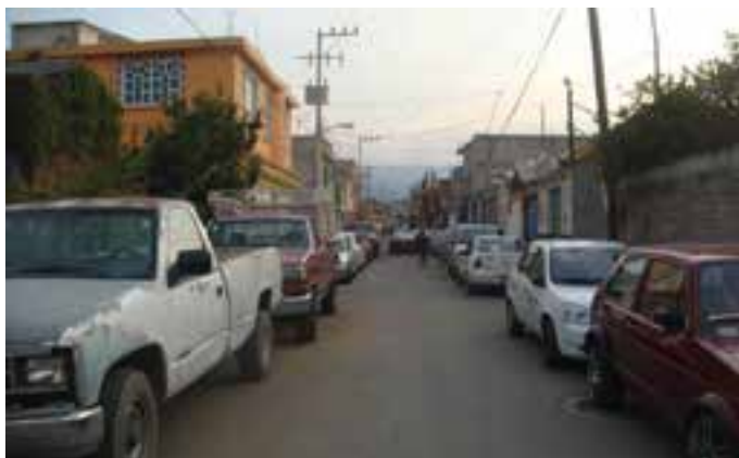
Figura 6.29 - Flujo vehicular en calle de Mixquic.
